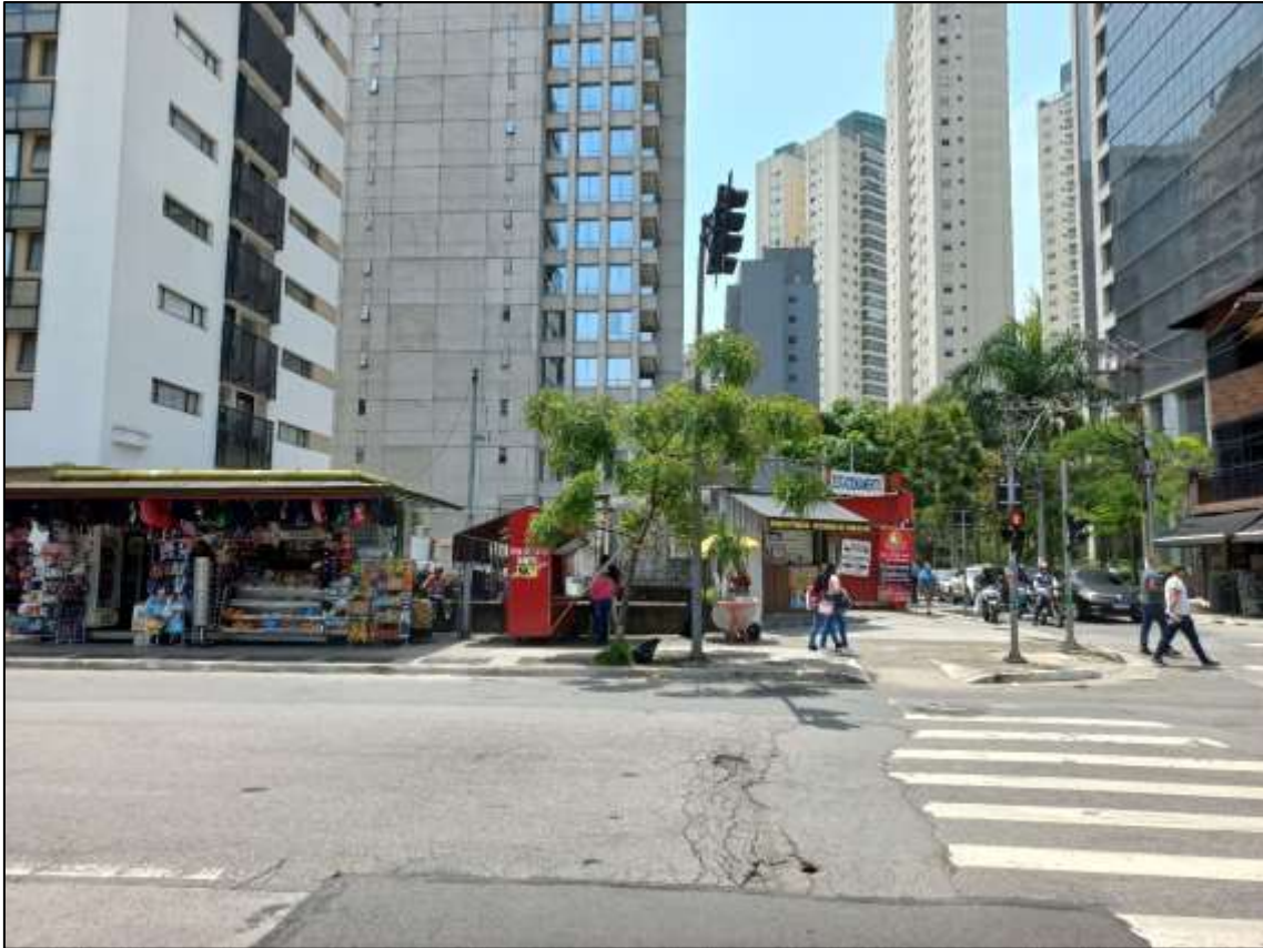
Fachada para Rua Gomes de Carvalho com alambrado, comercio de rua e banca de jornal na calçada
