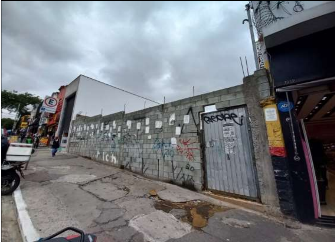
Fachada (ao lado do nº 1912)
