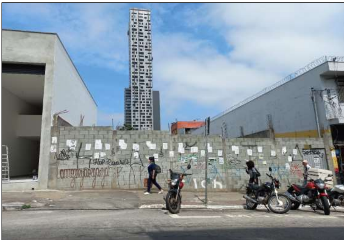
Fachada (área maior inclui antigo nº 1916)
