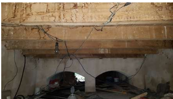
31 e 32. Barrotes sob o assoalho, no nível do porão. Podem-se observar manchas provocadas pela água que desce do telhado
