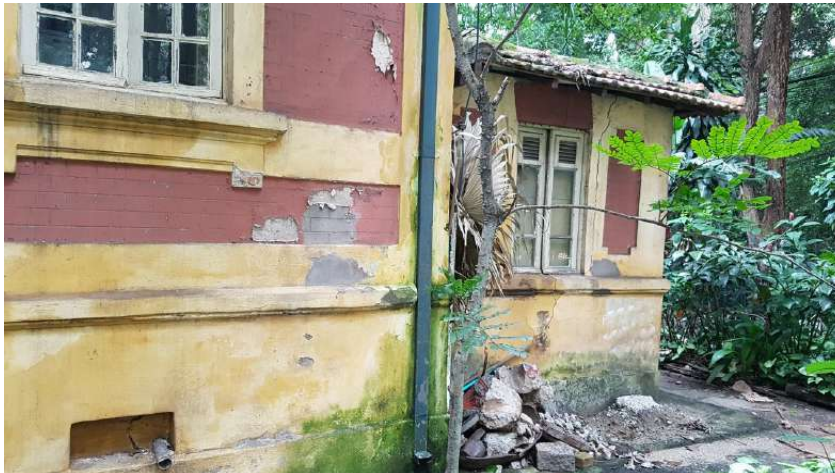
27. Fachada oeste: patologias recorrentes: desagregação do reboco, reboco de argamassa cimentícia, infiltração de águas pluviais. 28. Patologia recorrente: estufamento e desprendimento do reboco, decorrente de desagregação do reboco.
