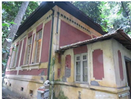
19. Patologia recorrente: desprendimento da pintura plástica. 20. Fachada oeste.
