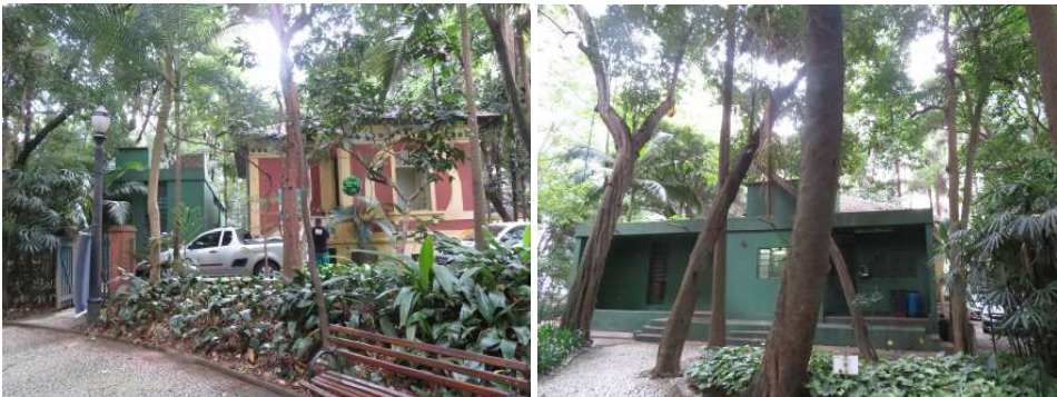
11. Fachada norte, com o ANEXO a leste. 12. Fachada leste do ANEXO.
