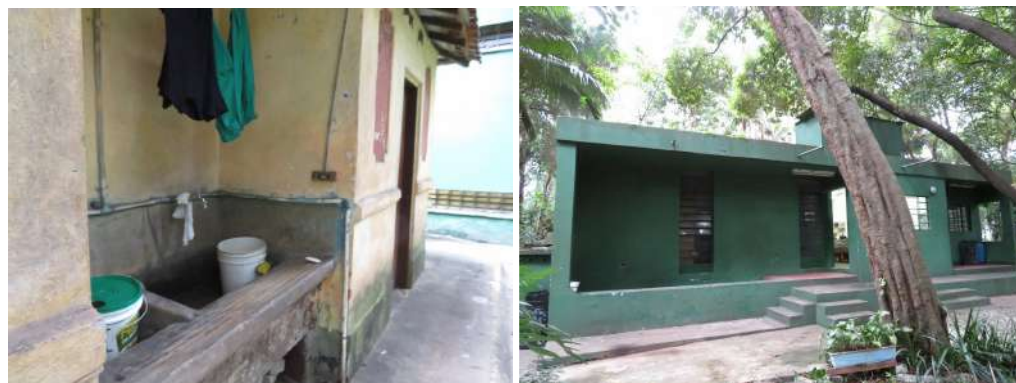
13. Fachada sul, “puxadinho”. 14. Fachada leste do ANEXO.
