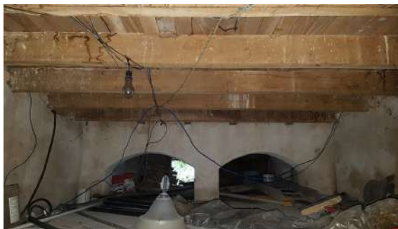
29 e 30. Barrotes sob o assoalho, no nível do porão. Podem-se observar manchas provocadas pela água que desce do telhado
