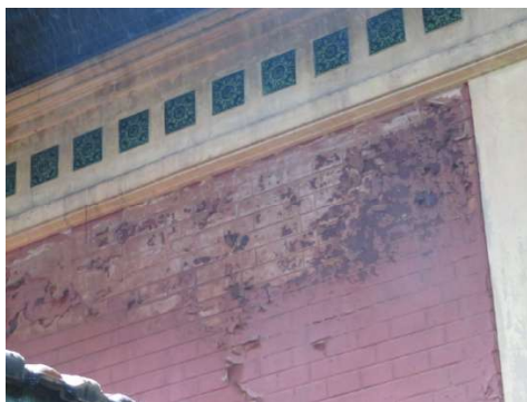
19. Patologia recorrente: desprendimento da pintura plástica. 20. Fachada oeste.
