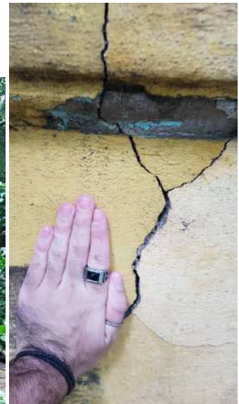
27. Fachada oeste: patologias recorrentes: desagregação do reboco, reboco de argamassa cimentícia, infiltração de águas pluviais. 28. Patologia recorrente: estufamento e desprendimento do reboco, decorrente de desagregação do reboco.
