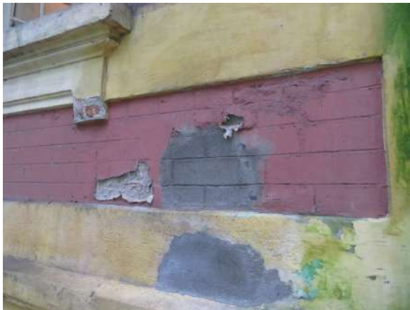
17. Patologia recorrente: obturação com reboco de argamassa cimentícia. 18. Fachada oeste.
