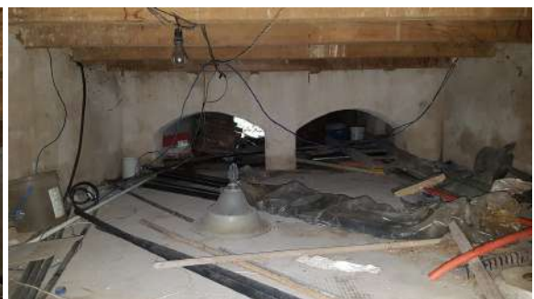
31 e 32. Barrotes sob o assoalho, no nível do porão. Podem-se observar manchas provocadas pela água que desce do telhado
