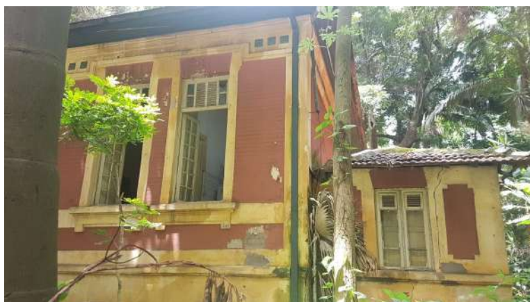
6. Fachada oeste, vendo-se o "puxadinho" à direita da imagem.
