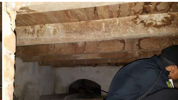
29 e 30. Barrotes sob o assoalho, no nível do porão. Podem-se observar manchas provocadas pela água que desce do telhado
