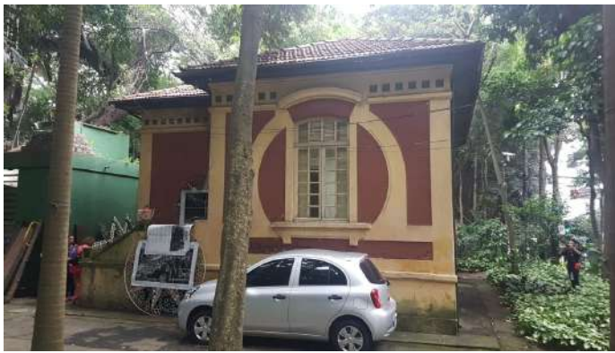
Fachada norte, e fachada leste
