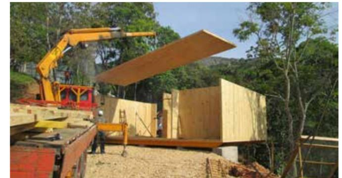
Transporte e montagem dos painéis em CLT
