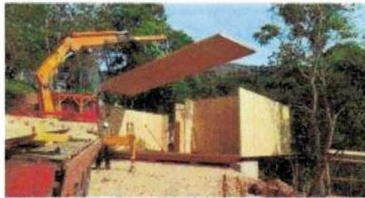
Transporte e montagem dos painéis em CLT
