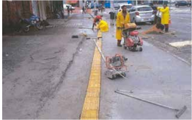
Revitalização de calçada na Av. Cupece
