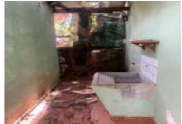
FOTO 42 – Casa do Zelador que será demolida
