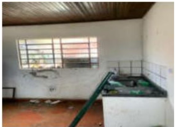
FOTO 41 – Casa do Zelador que será demolida
