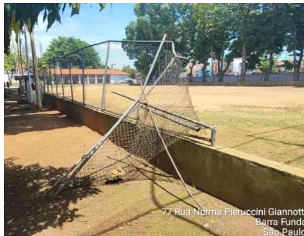
FOTO 38 – ALAMBRADO DANIFICADO
