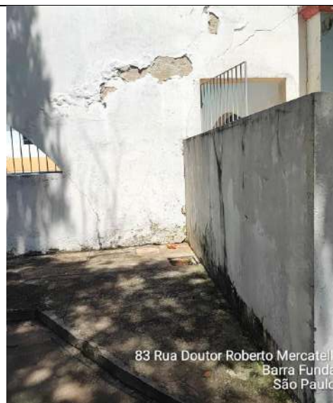
FOTO 06 – PAREDE COM REPAROS A EXECUTAR
