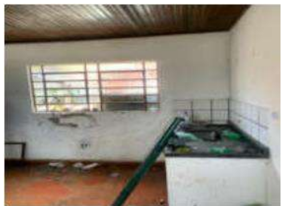
FOTO 41 – Casa do Zelador que será demolida
