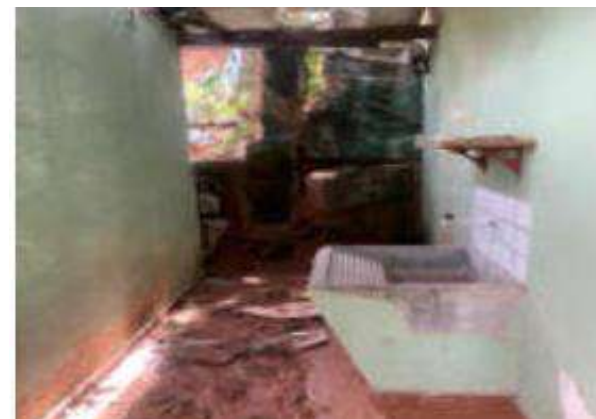
FOTO 42 – Casa do Zelador que será demolida
