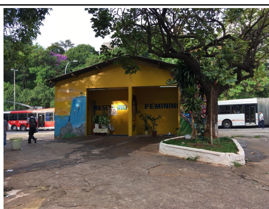
Imagem 9. Banheiro Praça Fernando Costa.
