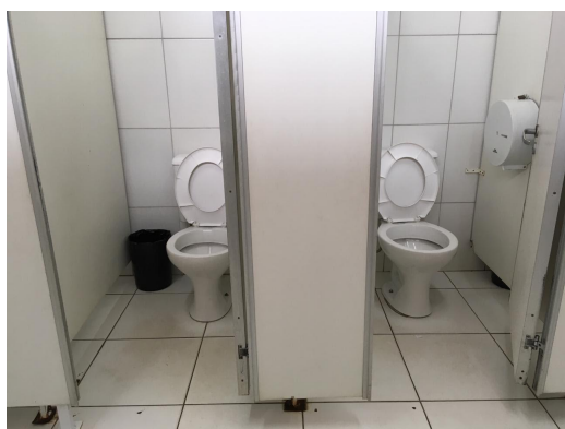
Imagem 5. Cabines do banheiro do Museu Catavento.
