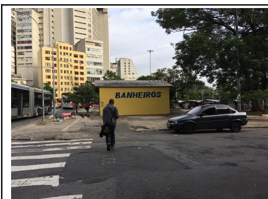
Imagem 8. Banheiro Praça Fernando Costa.
