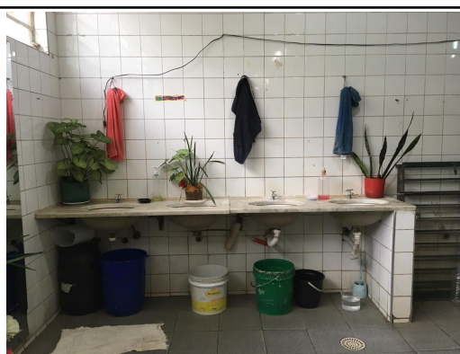
Imagem 11. Banheiro feminino Praça Fernando Costa.
