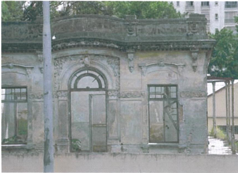
Detalhe fachada frontal. Notar estado dos ornamentos.
