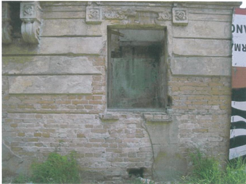
Detalhe fachada frontal. Notar estado dos revestimentos e ornamentos.
