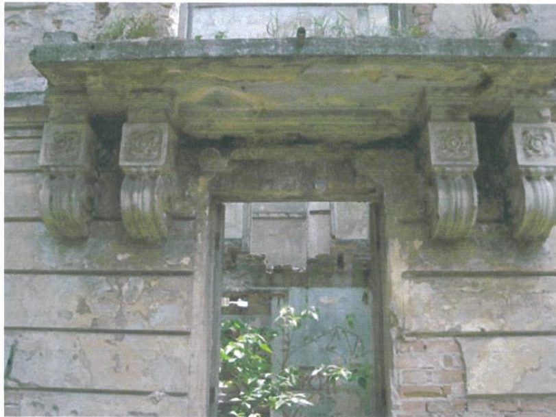
Detalhe da sacada frontal. Notar estado dos ornamentos.
