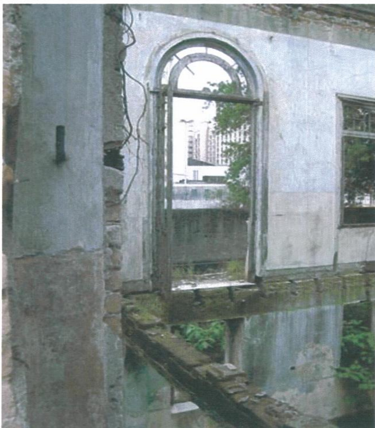
Vista interna da parede frontal. Notar ausência de piso e estado geral.
