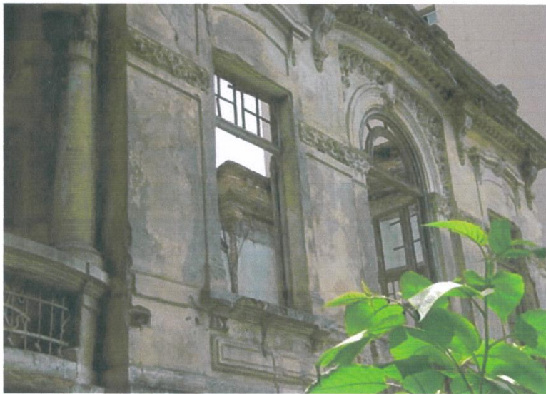
Detalhe fachada frontal. Notar estado dos ornamentos.
