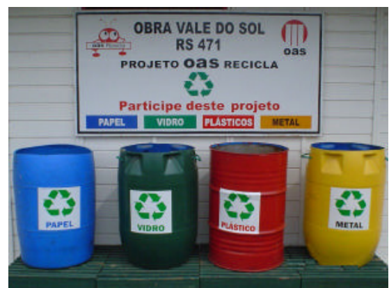
Lixeiras disponibilizadas no canteiro de obra
