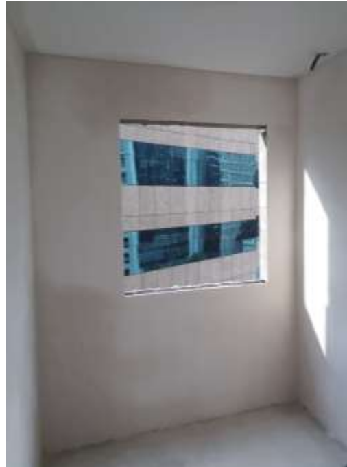
Execução de gesso
