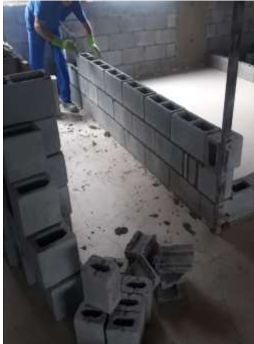
Execução de alvenaria
