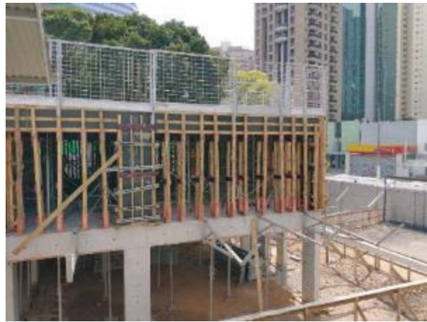
Vista Coliseu 1 – Escoras 1º Pavto.
