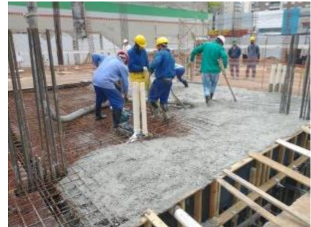
Concretagem de Vigas e Lajes
