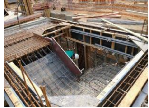
Execução de Armadura da Escada
