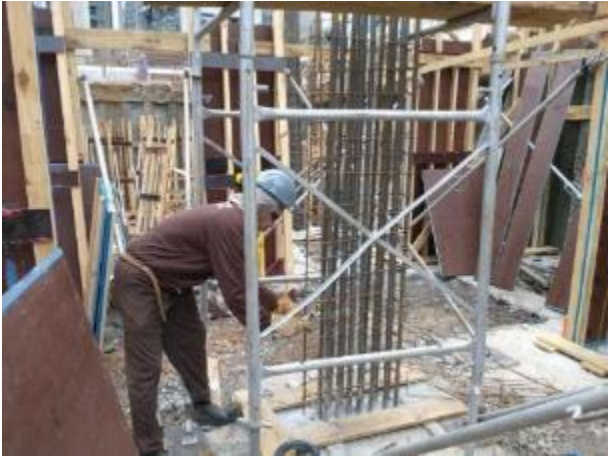
Execução de Armação de pilares
