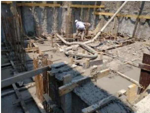
Execução de Concretagem de Fundações
