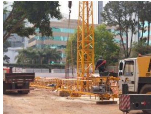
Montagem de Grua
