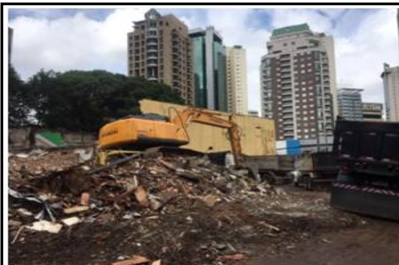
Serviços de demolição
