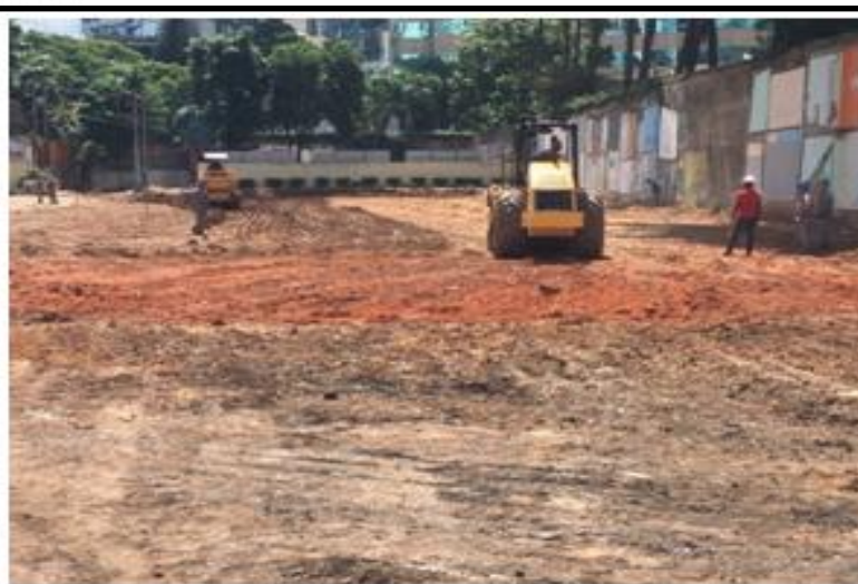
Serviços de terraplanagem
