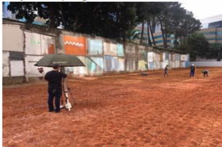
Serviços de locação das estacas
