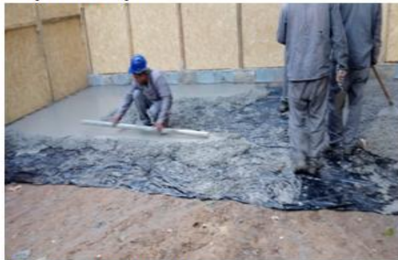
Concretagem de piso do canteiro
