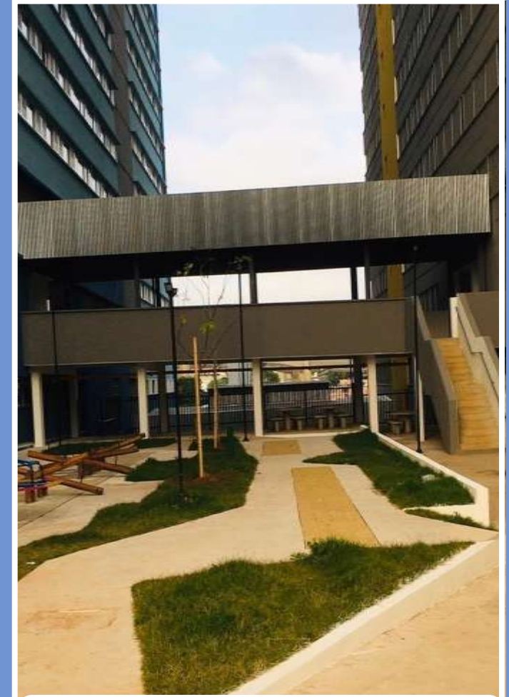
Área de lazer e passarela de acesso aos Blocos B e C
