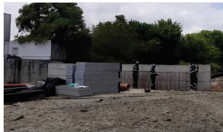
Execução de armação e demolição de calçada
