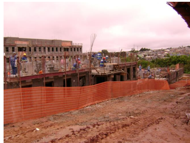
Chácara do Conde - Execução de alvenaria – 1º pavimento
