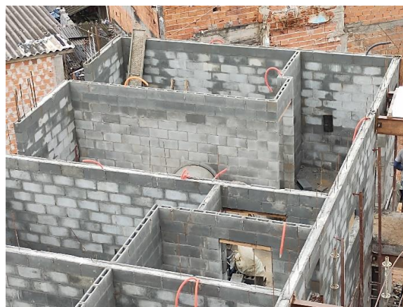
Bloco C – Execução de alvenarias de fechamento 1º pavimento
