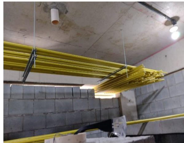
Torre A – Térreo – Instalação das tubulações de gás no abrigo
