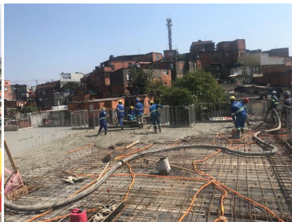
Cond. 6b – Concretagem da laje do barrilete
