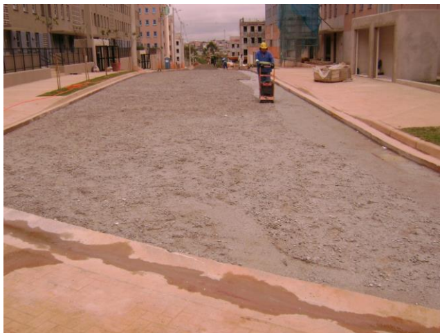
Chácara do Conde - Executando compactação do BGS para colocação dos intertravados
