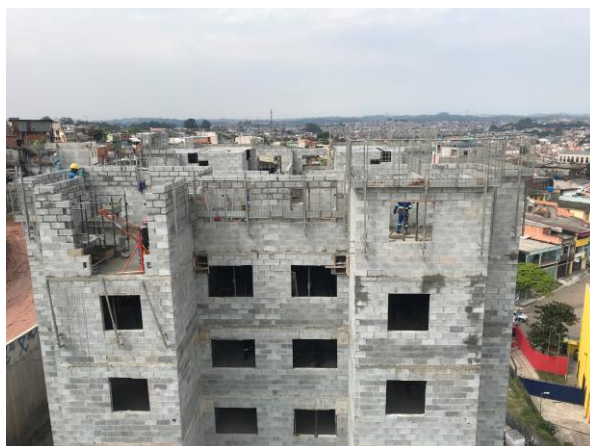
Cond. 6b – Execução da alvenaria do 6º pavimento
