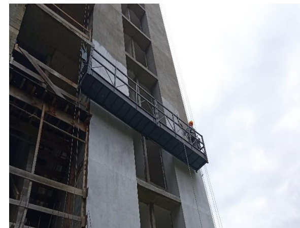
Bloco A - Execução de aplicação de fundo preparador na fachada
