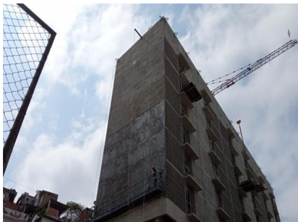
Bloco A - Revestimento externo
