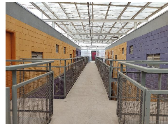
Bloco D – Corredor de acesso das unidades
