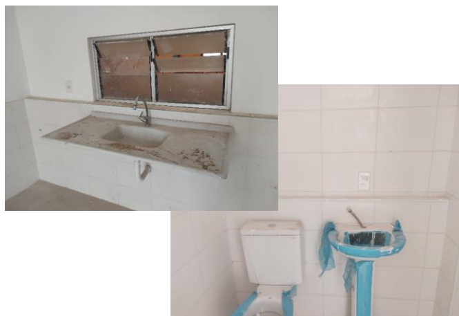
Blocos C e D – Instalação dos metais nas unidades
