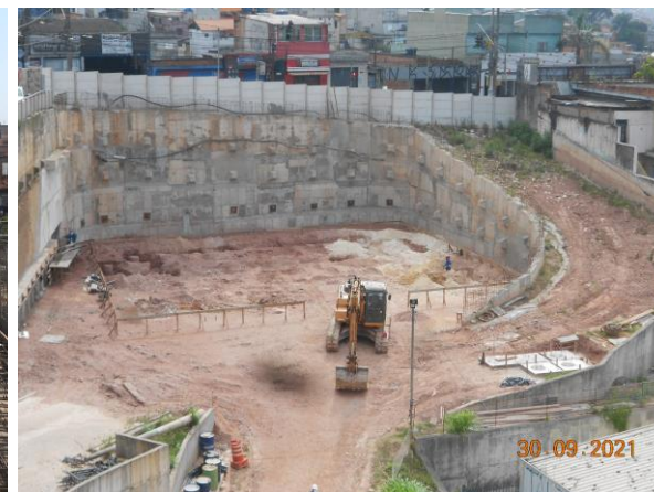
Cond. 7 – Escavação de vigas e brocas da fundação
