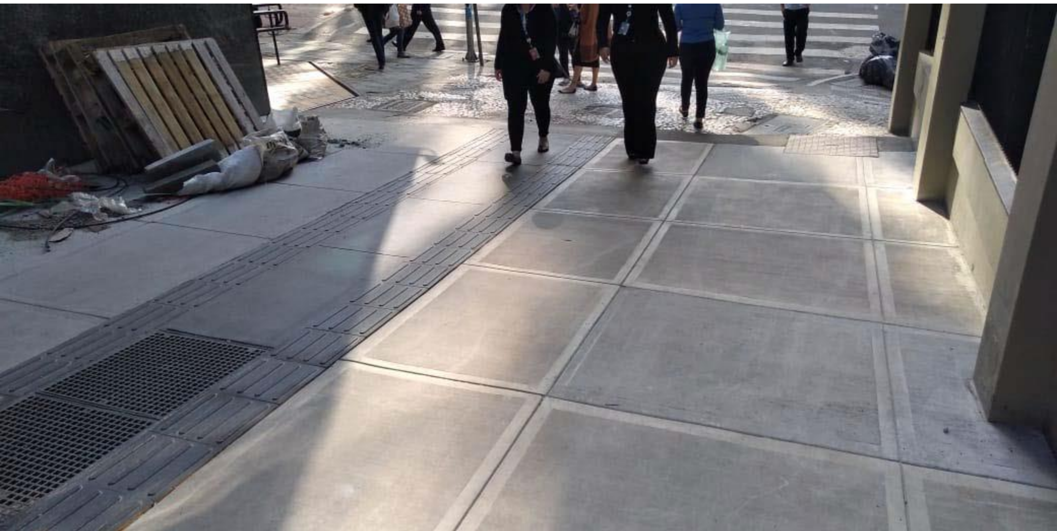
Imagem do Projeto Piloto em obras
