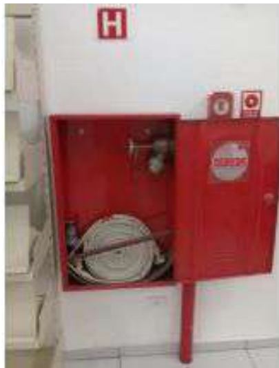
Instalação de esguicho com engate rápido no sagão da B. Anne Frank
