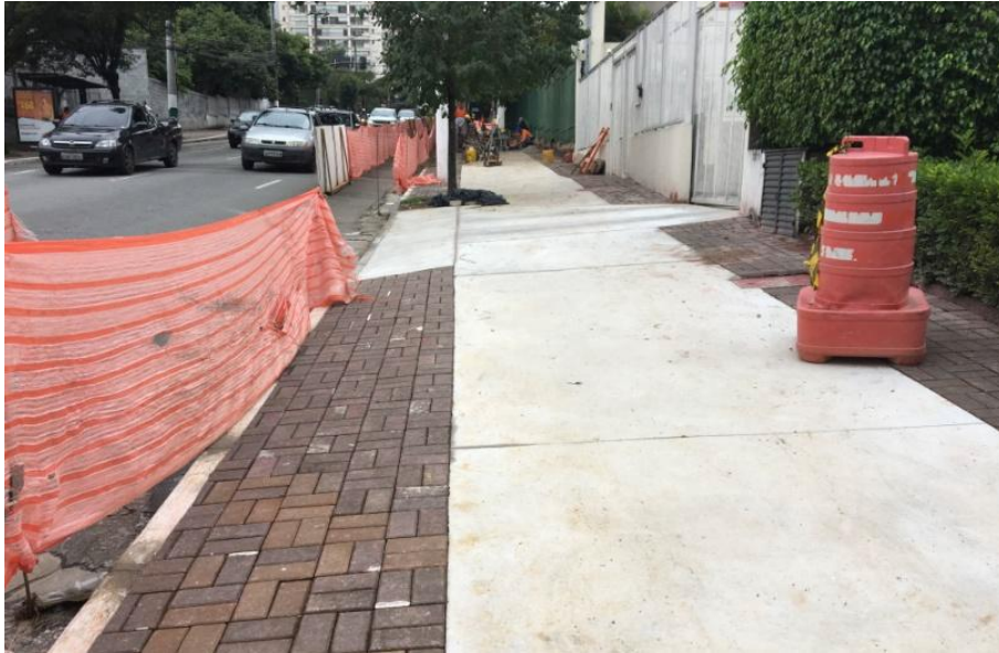
1. Execução de passeio. Rua Pedro de Toledo
