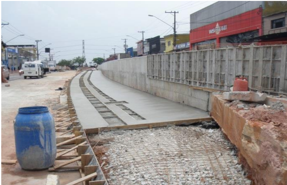
3. Corredor Leste Itaquera I
