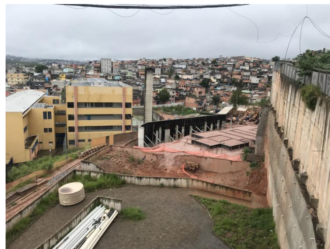
Área de implantação e muro de contenção Cond. 6B
