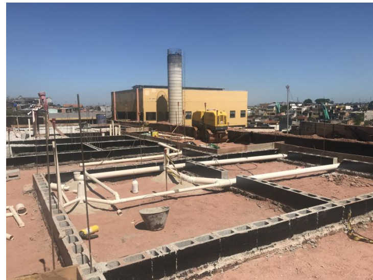
Execução das instalações hidráulicas da laje de transição Cond. 6A
