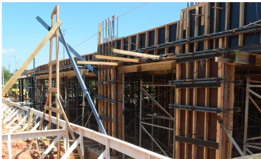
Montagem de Pilares Torre A Quadra 4
