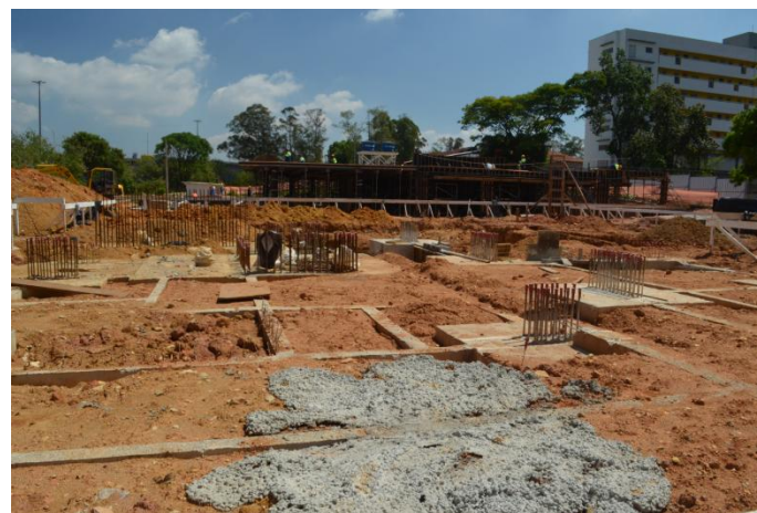
Fundação Torre B
