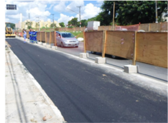
Execução de pavimento flexível
