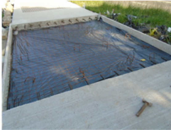
Execução de pavimento rígido
