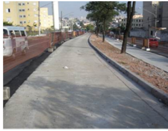
Execução de pavimento rígido
