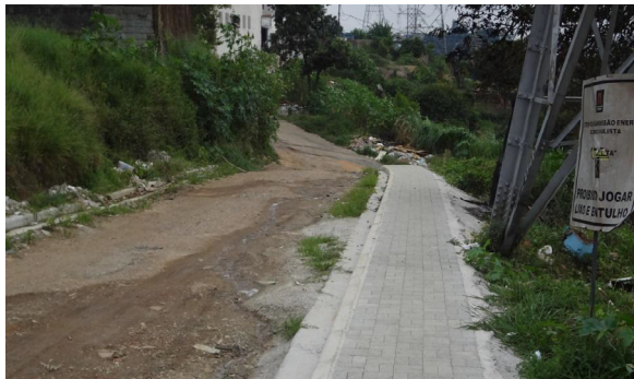
1. Construção de passeio e via. Capela do Socorro
