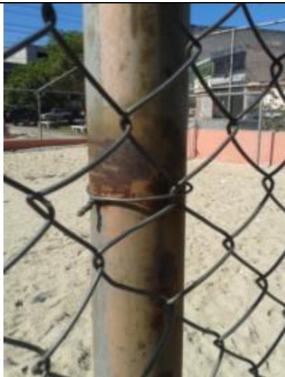
Fotos 1 e 2 – Estrutura Metálica do Alambrado apresenta ferrugem e falta de pintura.
