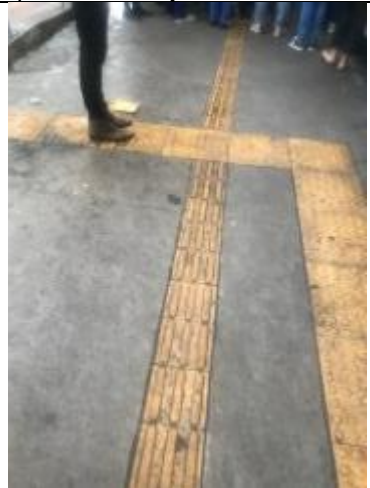
Foto 5: Piso podotátil e rejunte em boas condições.
