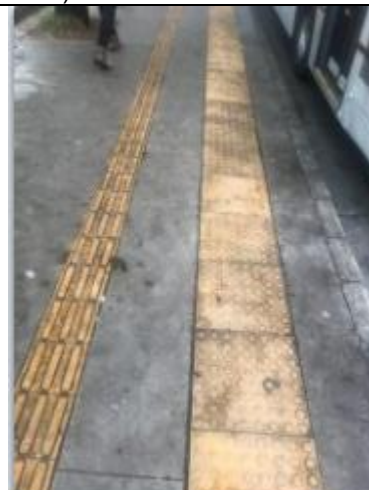
Foto 4: Piso podotátil e rejunte em boas condições.
