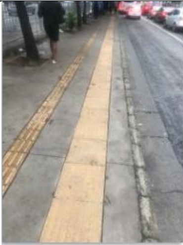
Foto 1: Piso podotátil e rejunte em boas condições.
