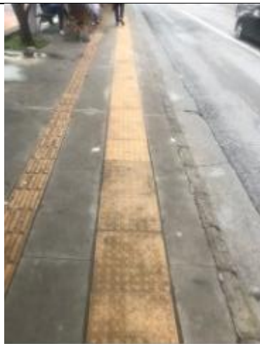
Foto 3: Piso podotátil e rejunte em boas condições.
