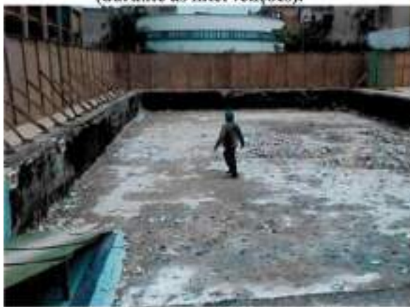
Figura 52 – Fragmento do relatório fotográfico utilizado como base para 1ª Medição (05/10/2015-05/11/2015) da execução contratual (durante as intervenções).
