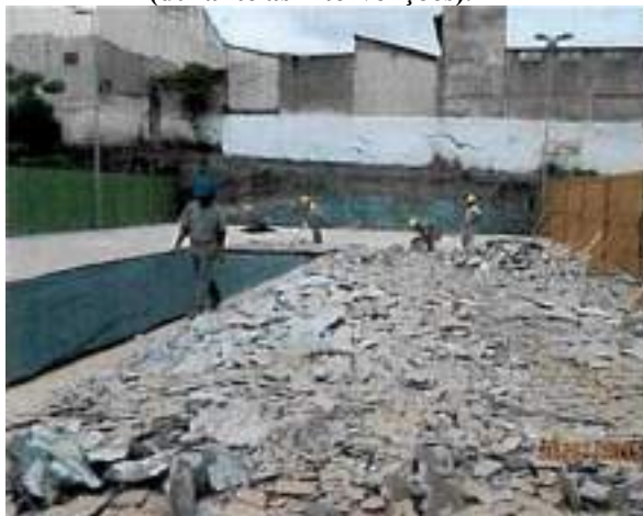
Figura 21– Fragmento do relatório fotográfico utilizado como base para 1ª Medição (30/12/2014-31/01/2015) da execução contratual (durante as intervenções).
