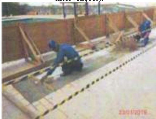
Figura 29– Fragmento do relatório fotográfico utilizado como base para 2ª Medição (23/01/2019) da execução contratual (durante as intervenções).
