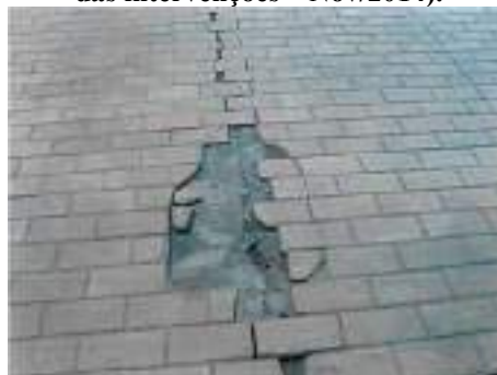
Figura 20– Fragmento do relatório fotográfico utilizado como base para elaboração do Memorial Descritivo (antes das intervenções – Nov/2014).
