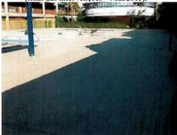
Figura 23– Fragmento do relatório fotográfico utilizado como base para 3ª Medição (01/04/2015-28/05/2015) da execução contratual (final das intervenções – Mai/2015).
