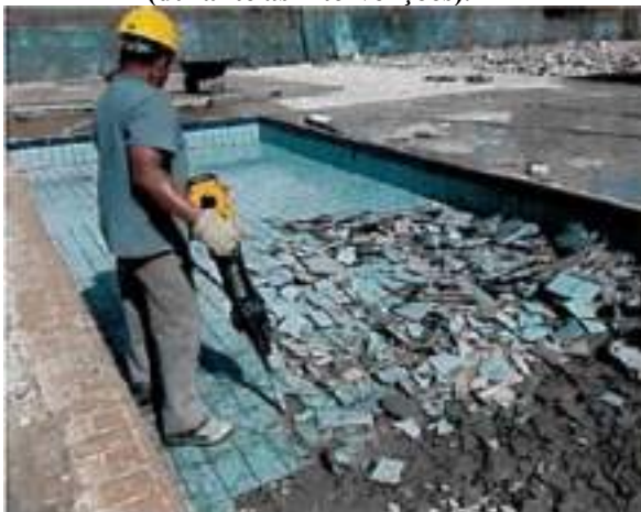
Figura 44 – Fragmento do relatório fotográfico utilizado como base para 1ª Medição (30/12/2014-31/01/2015) da execução contratual (durante as intervenções).
