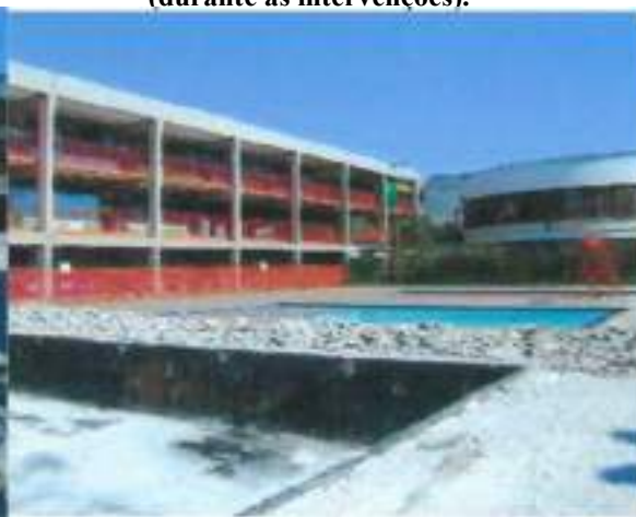
Figura 38– Fragmento do relatório fotográfico utilizado como base para 1ª Medição (06/10/2010-06/11/2010) da execução contratual (durante as intervenções).
