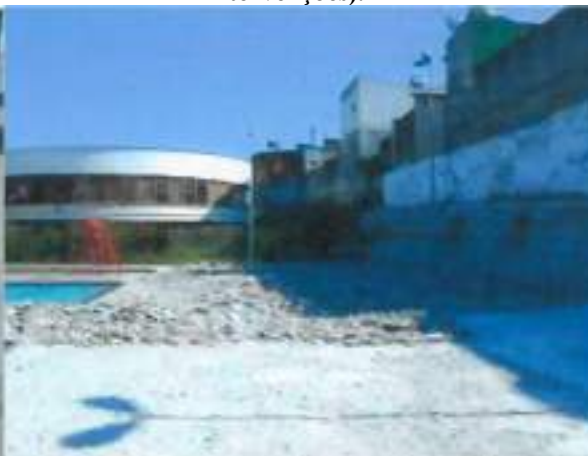
Figura 8 – Fragmento do relatório fotográfico utilizado como base para 1ª Medição (06/10/2010-06/11/2010) da execução contratual (durante as intervenções).
