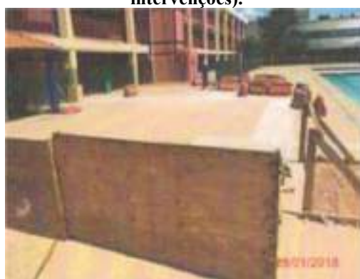
Figura 30– Fragmento do relatório fotográfico utilizado como base para 2ª Medição (23/01/2019) da execução contratual (durante as intervenções).
