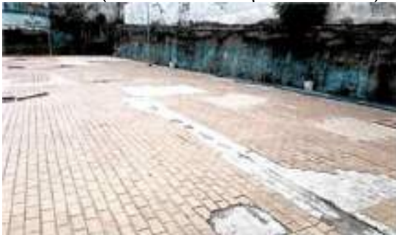
Figura 19– Fragmento do relatório fotográfico utilizado como base para elaboração do Memorial Descritivo (antes das intervenções – Nov/2014).
