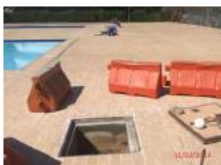
DURANTE/FINAL - PISO REJUNTADO
