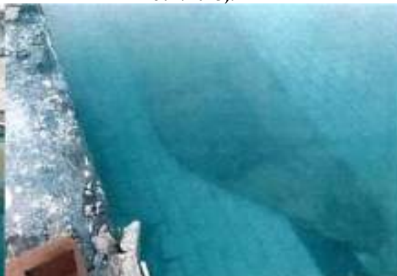
Figura 51 – Fragmento do relatório fotográfico utilizado como base para elaboração do Memorial Descritivo (antes das intervenções – Jun/2015).
