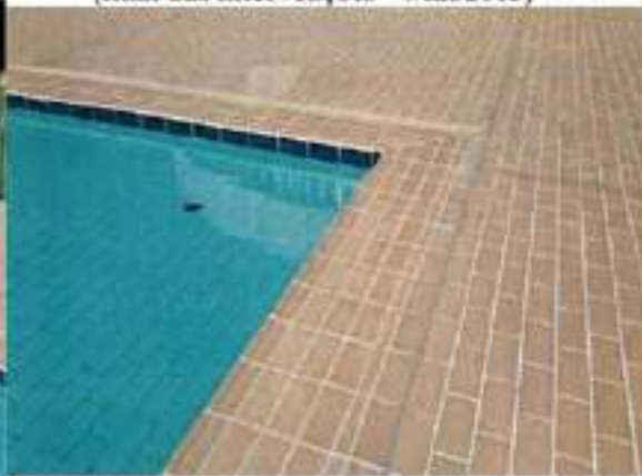
Figura 47 – Fragmento do relatório fotográfico utilizado como base para 3ª Medição (01/04/2015-28/05/2015) da execução contratual (final das intervenções – Mai/2015)
