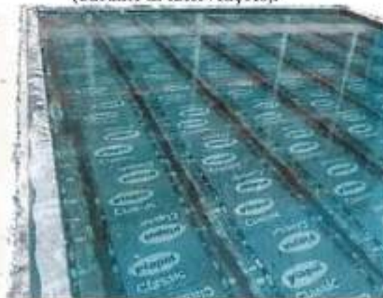
Figura 45 – Fragmento do relatório fotográfico utilizado como base para 1ª Medição (30/12/2014-31/01/2015) da execução contratual (durante as intervenções).
