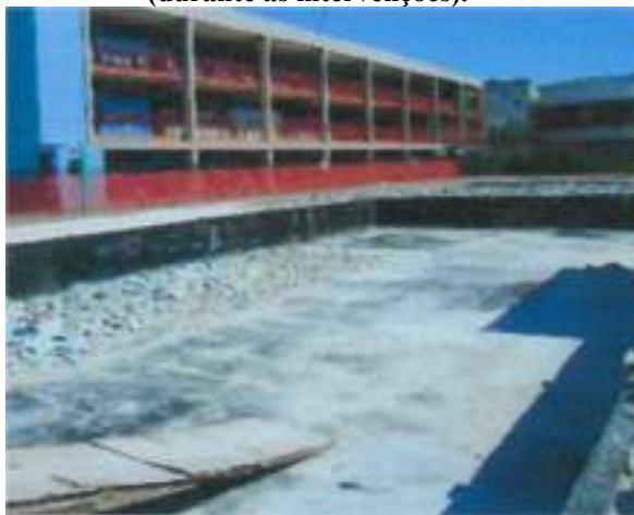
Figura 37 – Fragmento do relatório fotográfico utilizado como base para 1ª Medição (06/10/2010-06/11/2010) da execução contratual (durante as intervenções).
