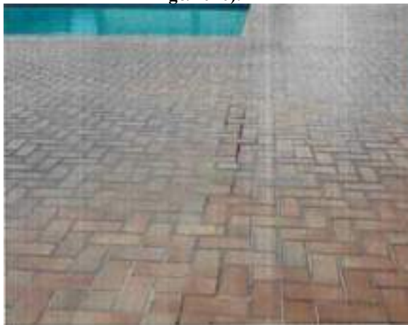
Figura 5 – Fragmento do relatório fotográfico utilizado como base para elaboração do Memorial Descritivo (antes das intervenções – Ago/2010).
