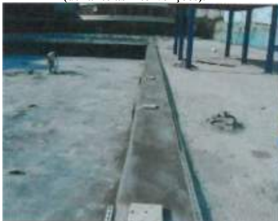
Figura 7 – Fragmento do relatório fotográfico utilizado como base para 1ª Medição (06/10/2010-06/11/2010) da execução contratual (durante as intervenções).
