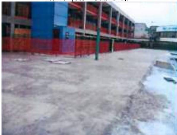
Figura 9 – Fragmento do relatório fotográfico utilizado como base para 2ª Medição (Até 03/01/2011) da execução contratual (final das intervenções – Out/2010).
