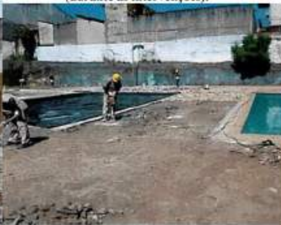
Figura 22– Fragmento do relatório fotográfico utilizado como base para 1ª Medição (30/12/2014-31/01/2015) da execução contratual (durante as intervenções).
