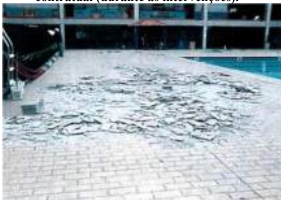
Figura 14– Fragmento do relatório fotográfico utilizado como base para 1ª Medição (26/06/2014 a 25/07/2014) da execução contratual (durante as intervenções).
