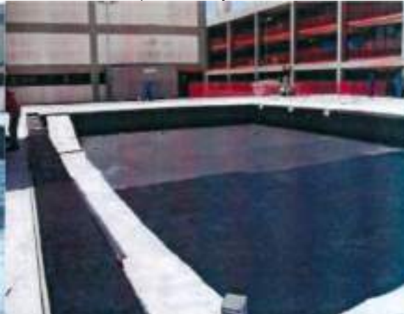
Figura 40 – Fragmento do relatório fotográfico utilizado como base para 2ª Medição (Até 03/01/2011) da execução contratual.
