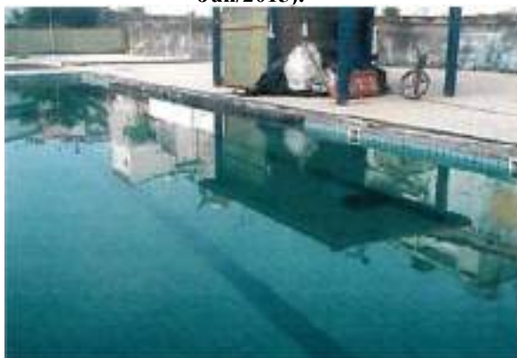
Figura 50 – Fragmento do relatório fotográfico utilizado como base para elaboração do Memorial Descritivo (antes das intervenções – Jun/2015).
