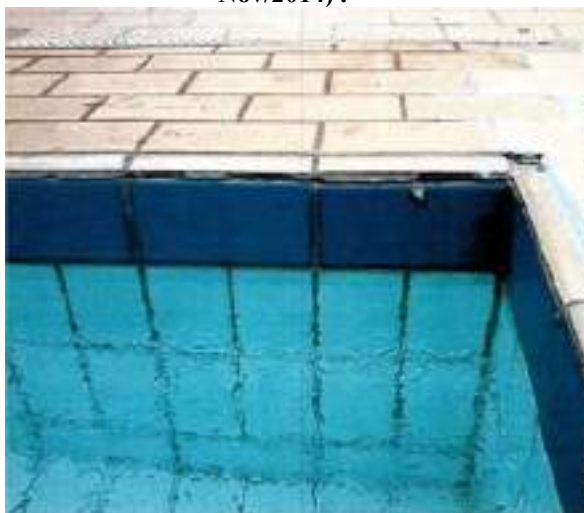
Figura 42 – Fragmento do relatório fotográfico utilizado como base para elaboração do Memorial Descritivo (antes das intervenções – Nov/2014) .
