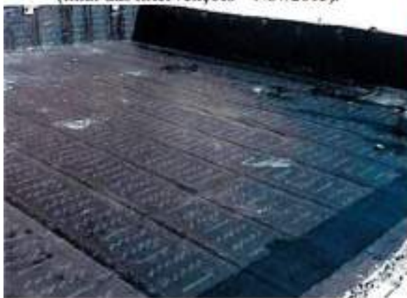
Figura 54 – Fragmento do relatório fotográfico utilizado como base para 2ª Medição (06/11/2015-05/12/2015) da execução contratual (final das intervenções – Nov/2015).
