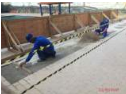
MANUTENÇÃO PISO ANTIDERRAPANTE
