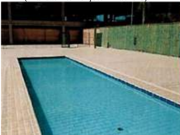
Figura 46 – Fragmento do relatório fotográfico utilizado como base para 3ª Medição (01/04/2015-28/05/2015) da execução contratual (final das intervenções – Mai/2015).
