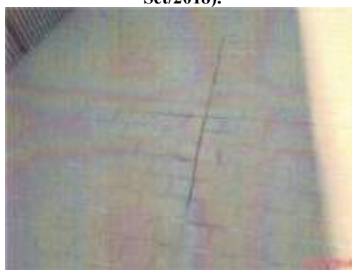
Figura 28– Fragmento do relatório fotográfico utilizado como base para elaboração do Memorial Descritivo (antes das intervenções – Set/2018).
