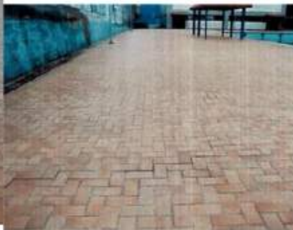
Figura 6 – Fragmento do relatório fotográfico utilizado como base para elaboração do Memorial Descritivo (antes das intervenções – Ago/2010).
