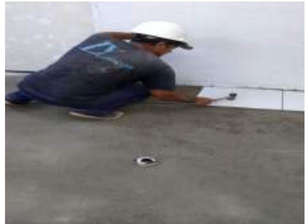
**Fotografia 12** - Substituição piso cerâmico
