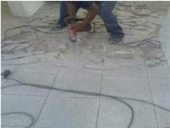
**Fotografia 11**- Demolição e substituição piso cerâmico
