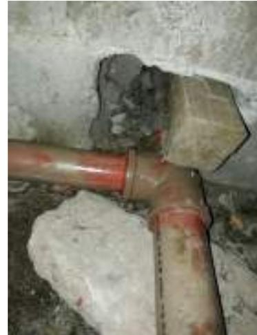
**Fotografia 56** - Substituição de tubo e conexões no barrilete.
