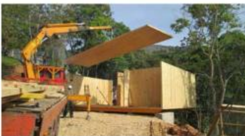
Transporte e montagem dos painéis em CLT
