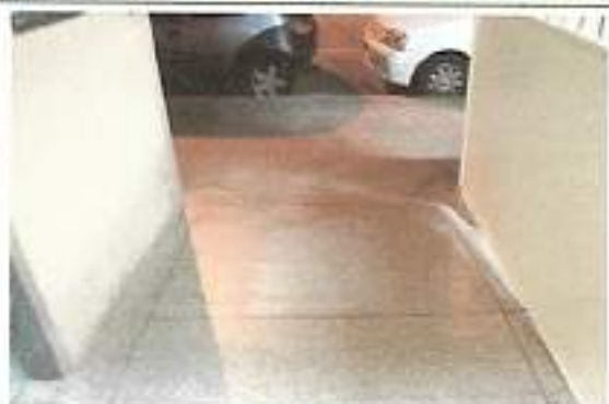
RAMPA ACESSIBILIDADE: ENTRA- DA
