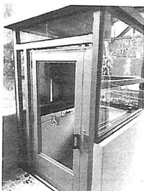
PLATAFORMA DE ACESSIBILIDADE
