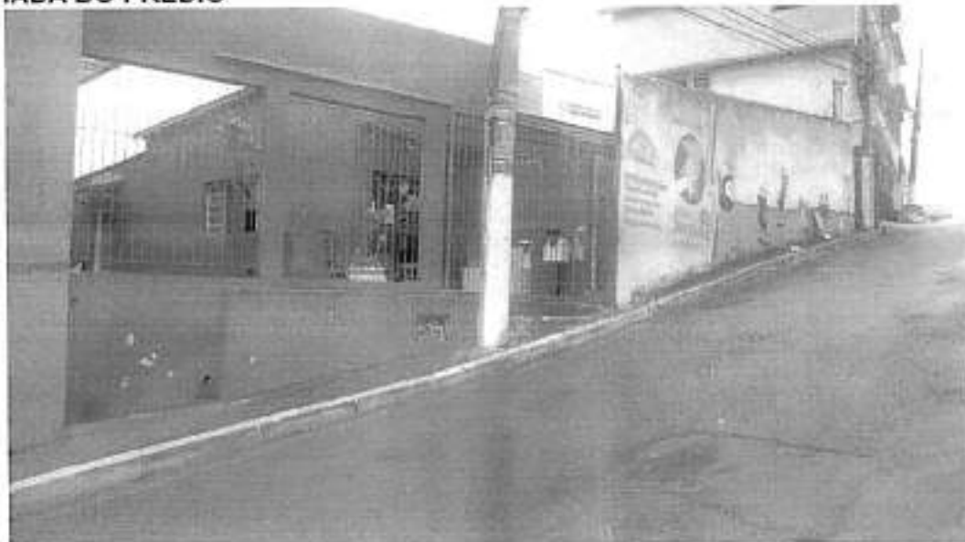
FACHADA DO PREDIO
