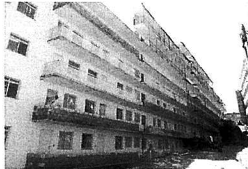
Vista do Bloco 3
