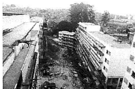
Vista geral - blocos 2 e 4
