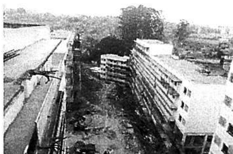
Vista geral - blocos 2 e 4
