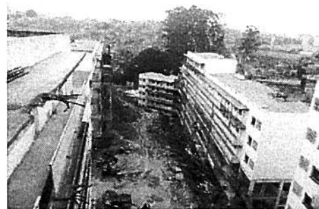
Vista geral - blocos 2 e 4
