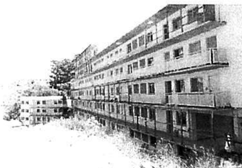
Vista geral - Bloco 4
