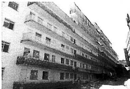
Vista do Bloco 3
