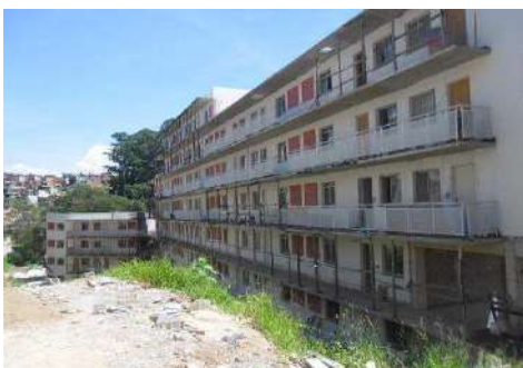
Vista geral - Bloco 4
