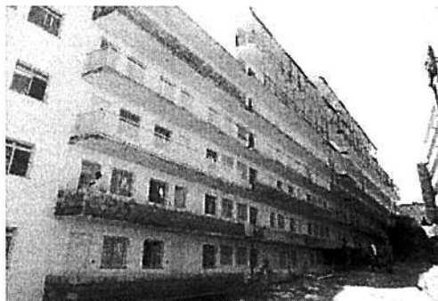
Vista do Bloco 3
