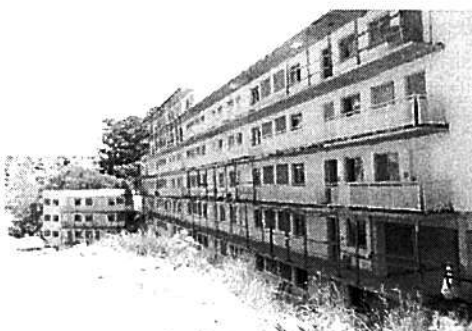
Vista geral - Bloco 4
