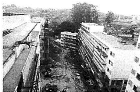
Vista geral - blocos 2 e 4
