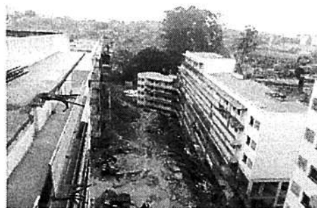
Vista geral - blocos 2 e 4
