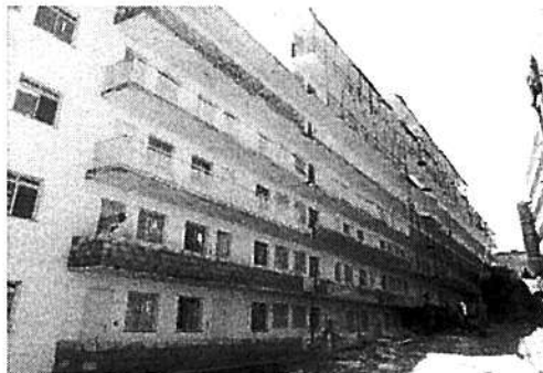
Vista do Bloco 3
