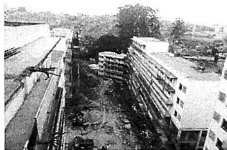
Vista geral - blocos 2 e 4
