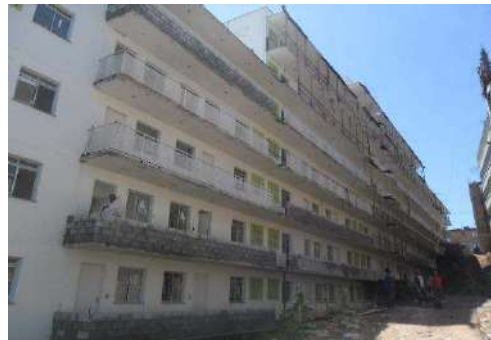
Vista do Bloco 3
