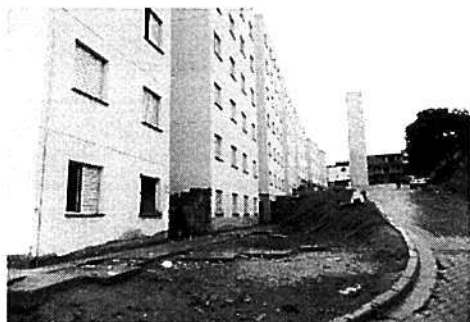
Vista do blocos 1, junto à entrada - pavimentação exec.
