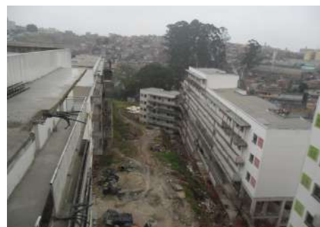
Vista geral - blocos 2 e 4
