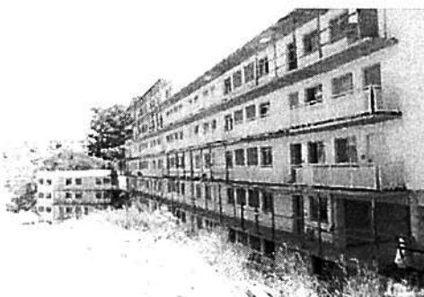
Vista geral - Bloco 4
