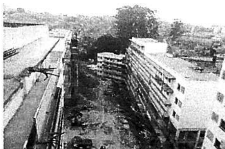
Vista geral - blocos 2 e 4
