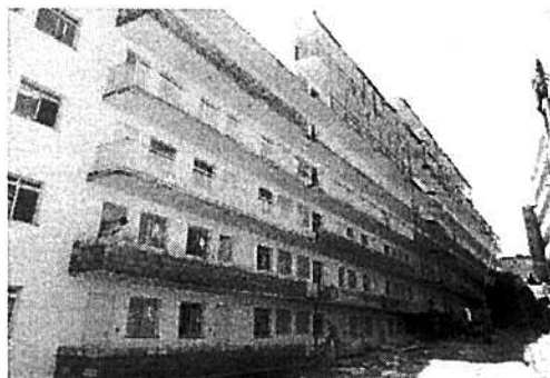
Vista do Bloco 3
