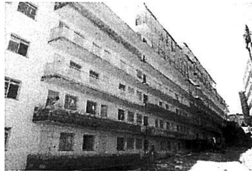
Vista do Bloco 3
