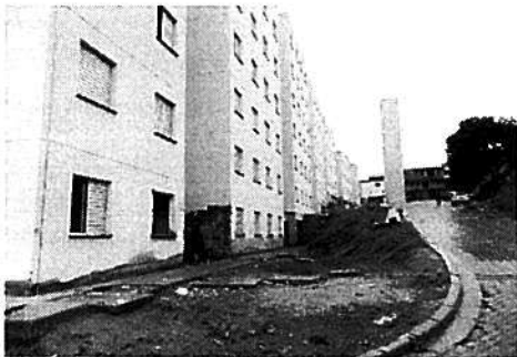
Vista do blocos 1, junto à entrada - pavimentação exec.
