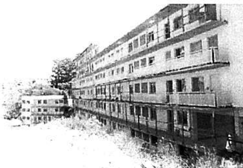
Vista geral - Bloco 4
