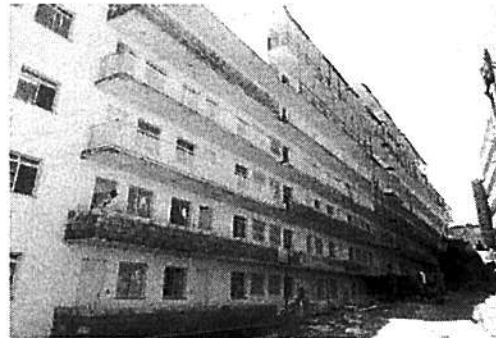
Vista do Bloco 3
