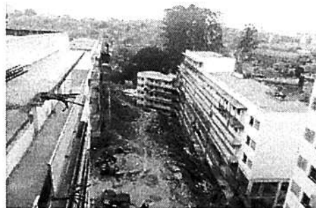
Vista geral - blocos 2 e 4
