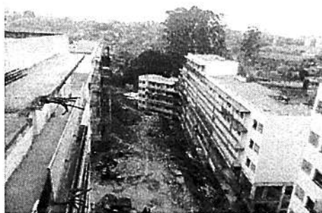
Vista geral - blocos 2 e 4
