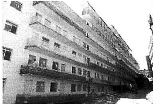
Vista do Bloco 3
