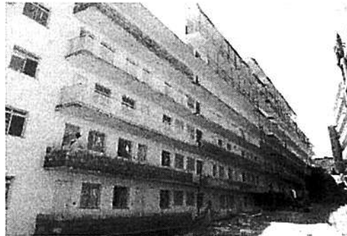
Vista do Bloco 3
