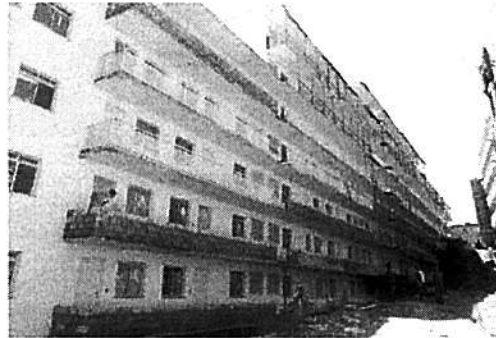
Vista do Bloco 3
