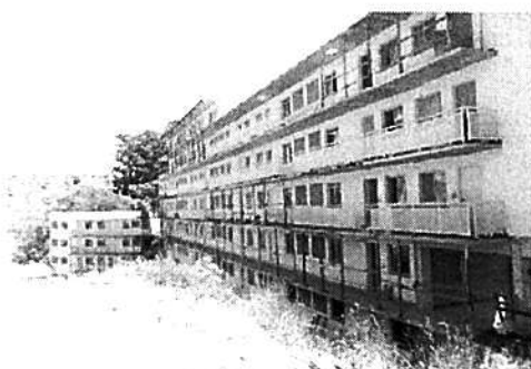
Vista geral - Bloco 4
