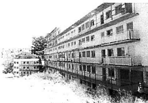
Vista geral - Bloco 4
