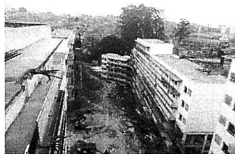
Vista geral - blocos 2 e 4
