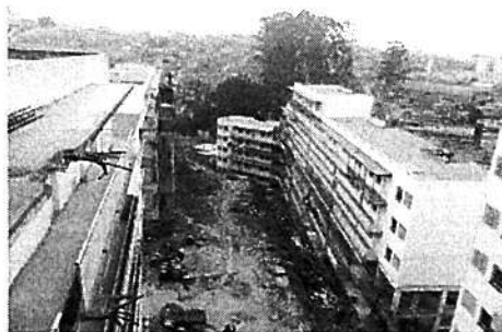
Vista geral - blocos 2 e 4
