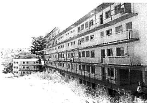
Vista geral - Bloco 4
