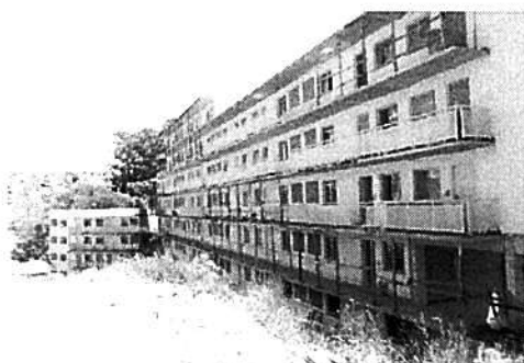
Vista geral - Bloco 4
