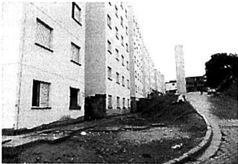
Vista dos blocos 1, junto à entrada - pavimentação exec.
