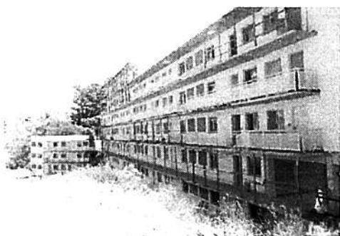
Vista geral - Bloco 4
