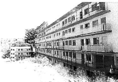
Vista geral - Bloco 4
