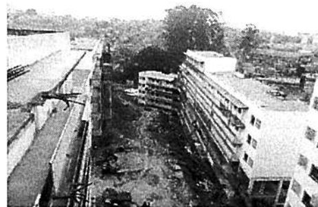
Vista geral - blocos 2 e 4
