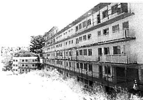
Vista geral - Bloco 4
