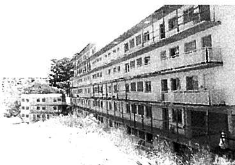
Vista geral - Bloco 4
