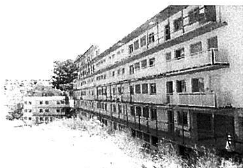
Vista geral - Bloco 4
