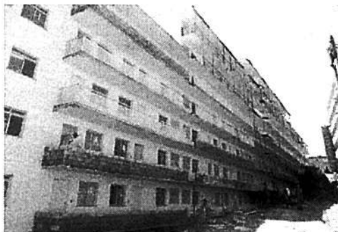
Vista do Bloco 3
