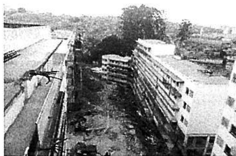
Vista geral - blocos 2 e 4
