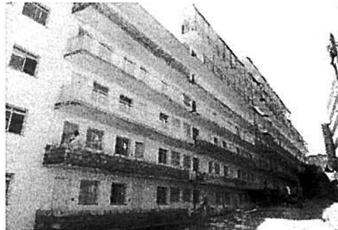
Vista do Bloco 3
