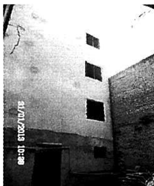
Foto 3: Fachada posterior do bloco anterior
