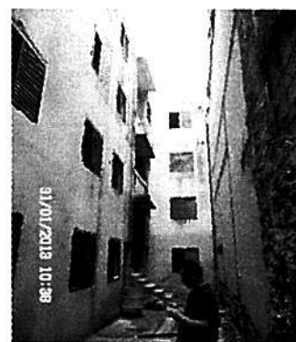
Foto 4: Fachada lateral do bloco posterior
