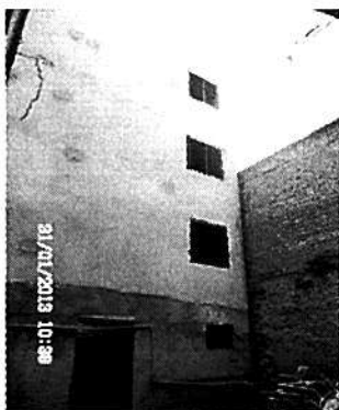
Foto 3: Fachada posterior do bloco anterior
