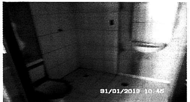
Foto 2: Peças sanitárias e revestimento em banheiro
