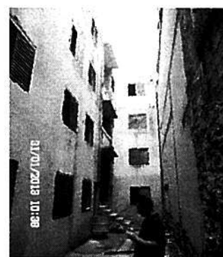
Foto 4: Fachada lateral do bloco posterior
