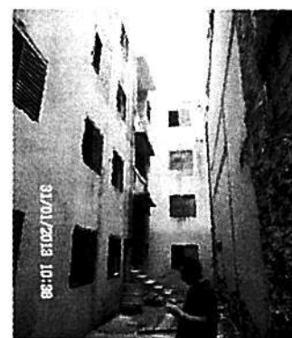
Foto 4: Fachada lateral do bloco posterior
