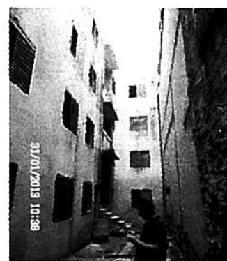
Foto 4: Fachada lateral do bloco posterior
