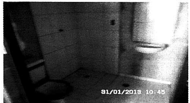
Foto 2: Peças sanitárias e revestimento em banheiro
