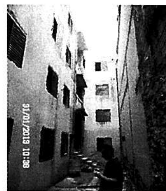
Foto 4: Fachada lateral do bloco posterior
