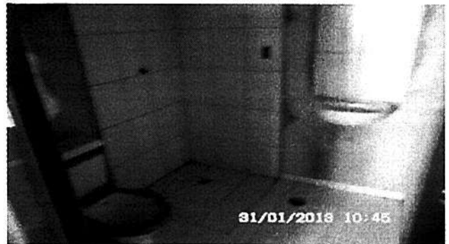
Foto 2: Peças sanitárias e revestimento em banheiro
