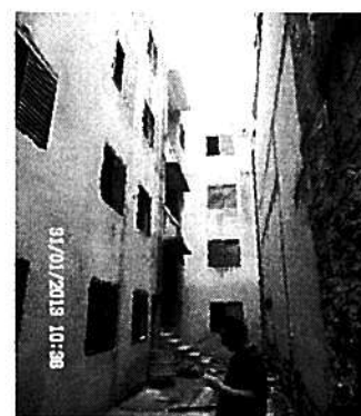
Foto 4: Fachada lateral do bloco posterior
