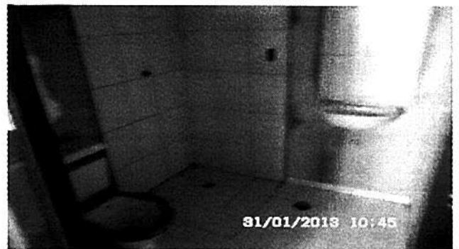
Foto 2: Peças sanitárias e revestimento em banheiro
