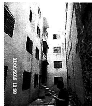
Foto 4: Fachada lateral do bloco posterior
