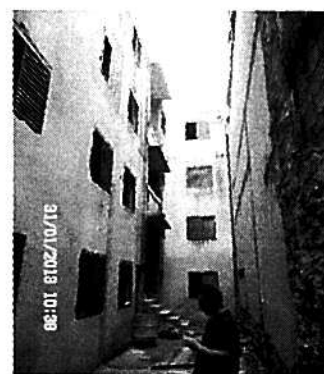
Foto 4: Fachada lateral do bloco posterior
