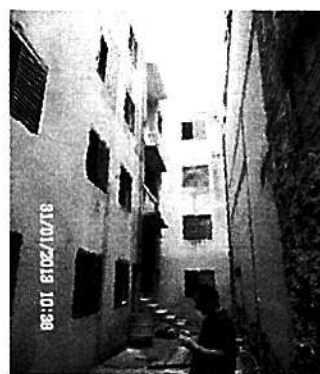
Foto 4: Fachada lateral do bloco posterior
