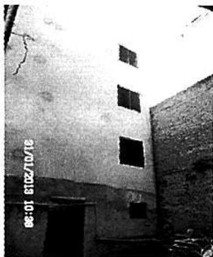
Foto 3: Fachada posterior do bloco anterior
