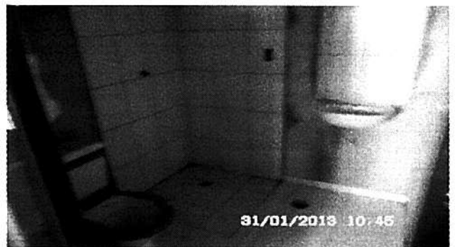
Foto 2: Peças sanitárias e revestimento em banheiro
