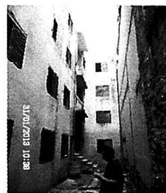
Foto 4: Fachada lateral do bloco posterior
