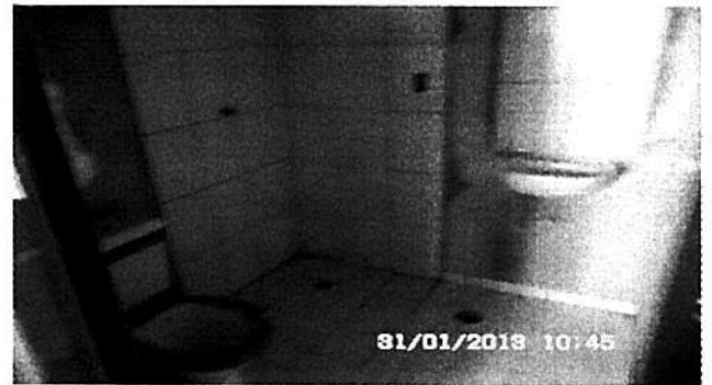
Foto 2: Peças sanitárias e revestimento em banheiro
