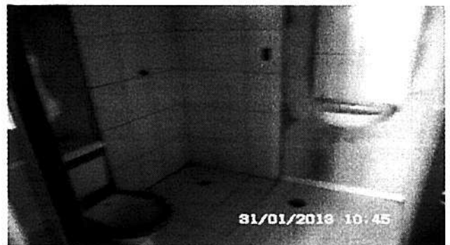
Foto 2: Peças sanitárias e revestimento em banheiro
