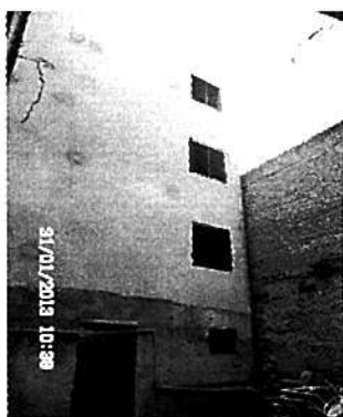
Foto 3: Fachada posterior do bloco anterior
