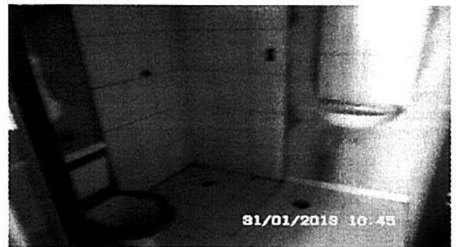
Foto 2: Peças sanitárias e revestimento em banheiro
