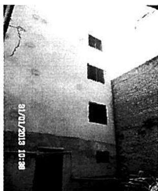
Foto 3: Fachada posterior do bloco anterior
