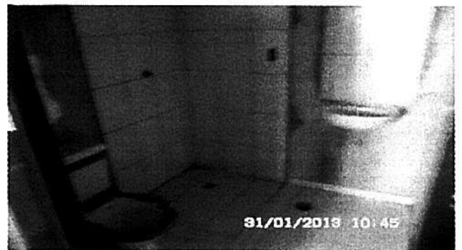
Foto 2: Peças sanitárias e revestimento em banheiro
