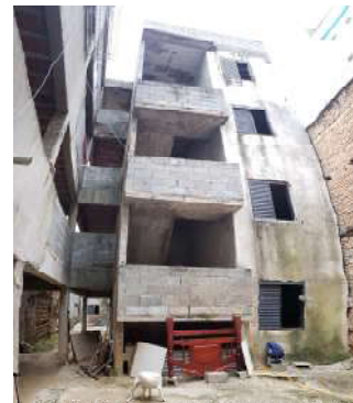
Foto 2: Vista interna do empreendimento
