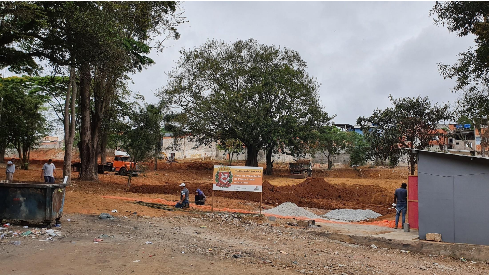
Obras de Implantação em andamento – setembro/2021
