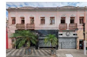
SITUAÇÃO ATUAL (MARÇO DE 2021) DA FACHADA DA CONSTRUÇÃO
