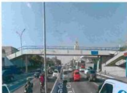
Foto 2 – Vista antiga da passarela, Dr. José Granadeiro Guimarães, antes de sua remoção, foto obtida pela internet.
