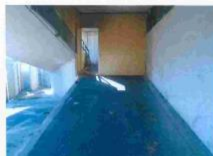
Foto 6 – Vista da rampa de acesso a passarela lado Moema
