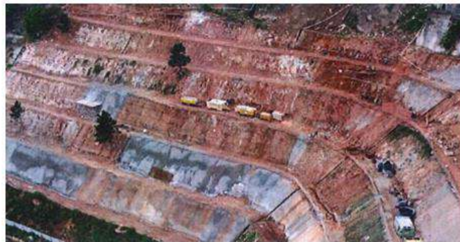
Morro dos Macacos – Chumbador/ Projetado - Foto: mai./23.
