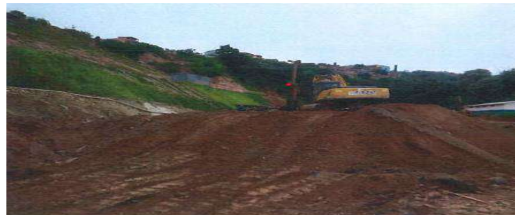
Escavação e Carga de Material – Provisão 3 (Trecho 1) -Foto: jun./23.
