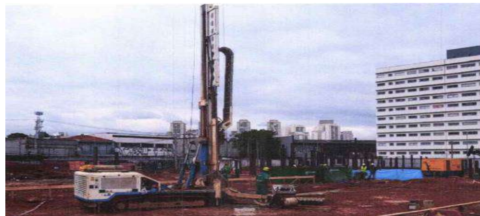
Torre 2 - Execução de Estaca Raiz – Fotos: mai./23.
