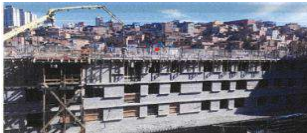
Laje – Concretagem. - Fotos: mai./23.
