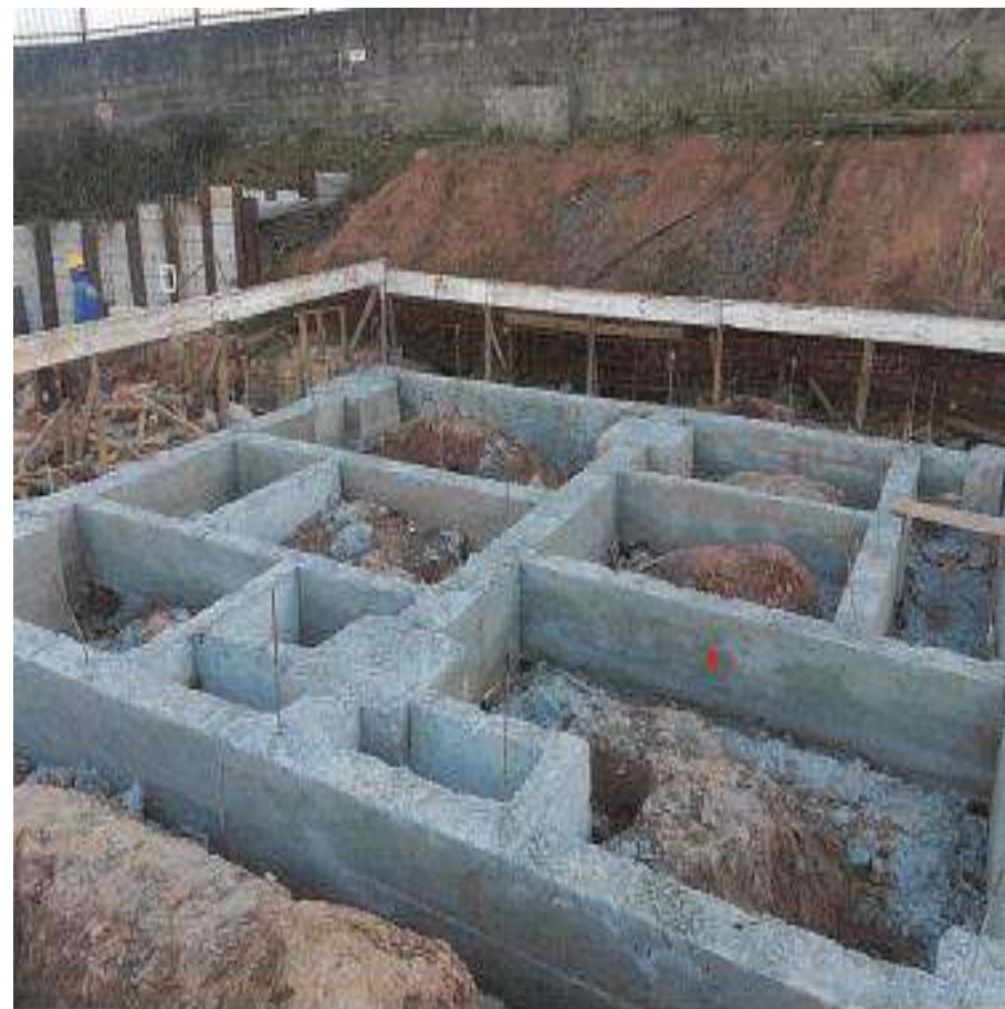
Vigas Baldrame – Fotos: abr./23.
