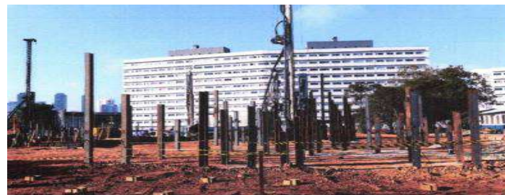
Torre 1 – Cravação de Perfis metálicos - Fotos: mai./23.
