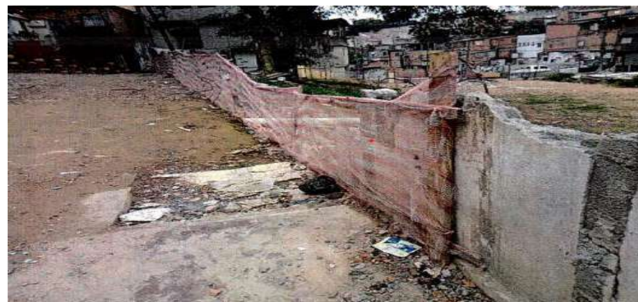
Execução da Sinalização do Trecho 1 – Área de Demolição - Fotos: mai./23.
