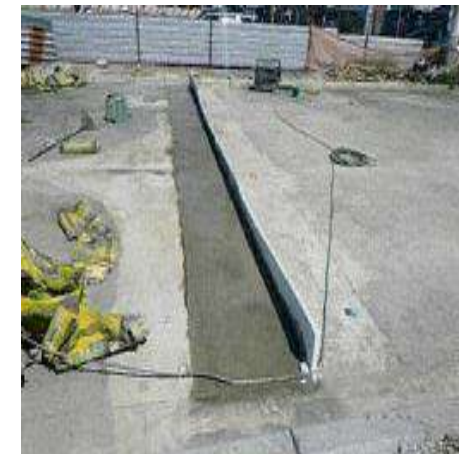
Fornecimento de Colocação de Junta de Dilatação Foto: abr./23.
