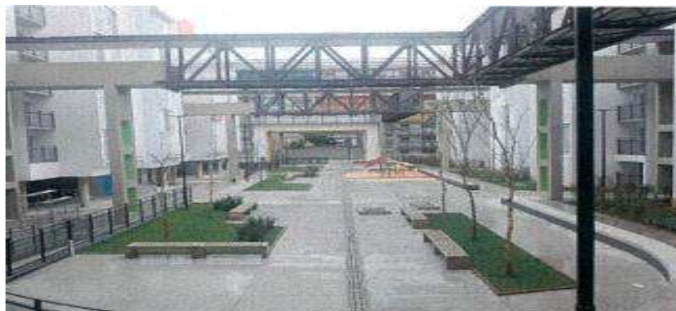
Execução de Steel Deck – Fotos: mar./23.
