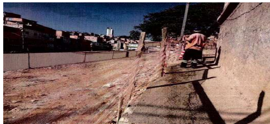
Execução da Sinalização do Trecho 1 – Área de Demolição - Fotos: mai./23.
