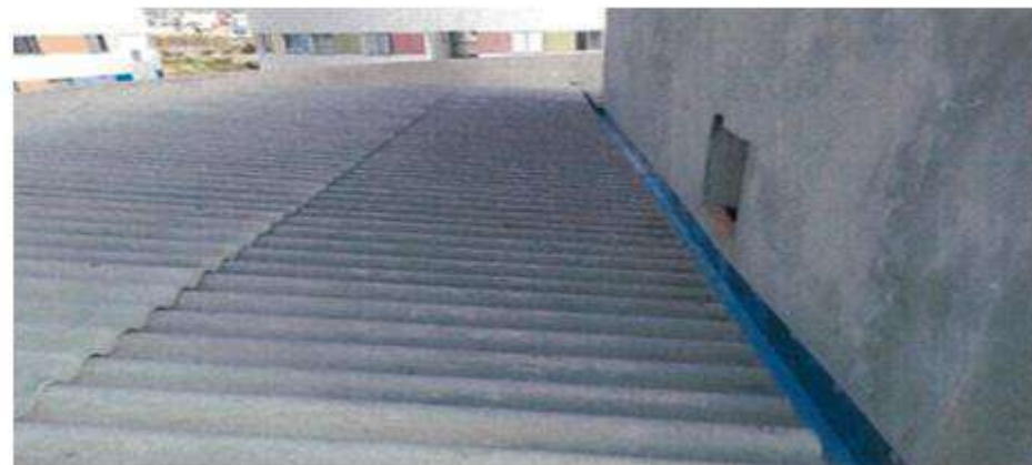
Condomínio 5 – Execução de Telhado– Fotos: mai./23.
