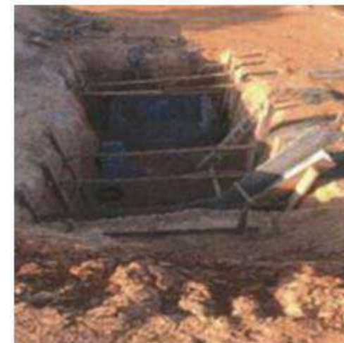
Vila do Sol – Execução de Rede de Drenagem Rap 6 - Foto: mai./23
