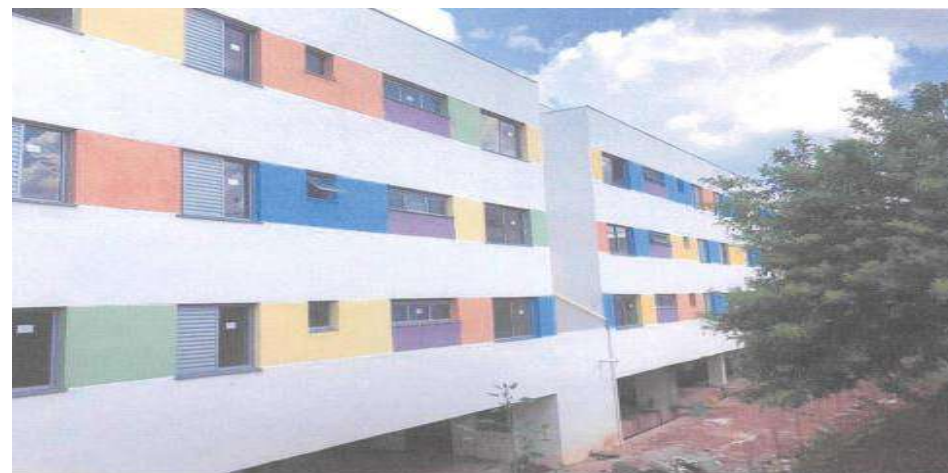
Pintura Externa – Fotos: mai./23.
