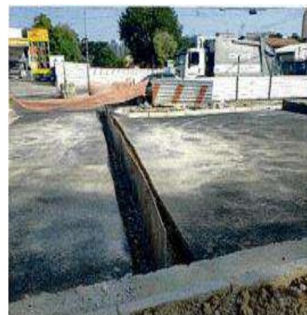
Limpeza de Junta de Dilatação Fotos: abr./23.
