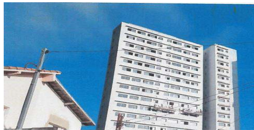
Torre B – Pintura da Fachada- Foto: mai./23.
