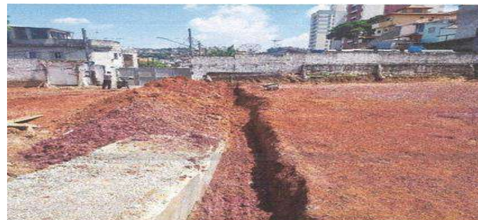
Condomínio A – Escavação Rede de Esgoto - Foto: abr./23.
