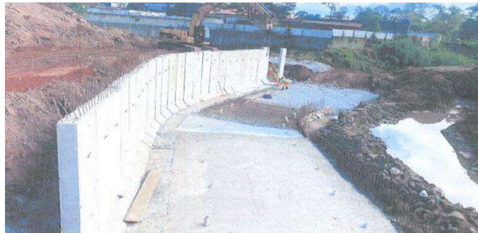
Vargem Grande – Área 231 – Execução do Córrego do Caulim – Laje de Fundo Concretada - Foto: mai./23.
