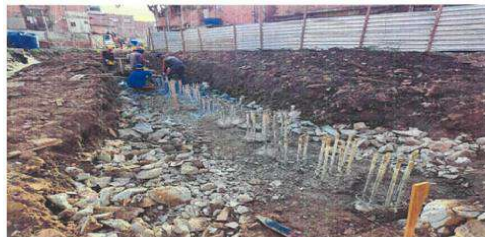
Fase 4 – Corte e Reparo de Cabeça de Estaca – Fotos: mai./23.
