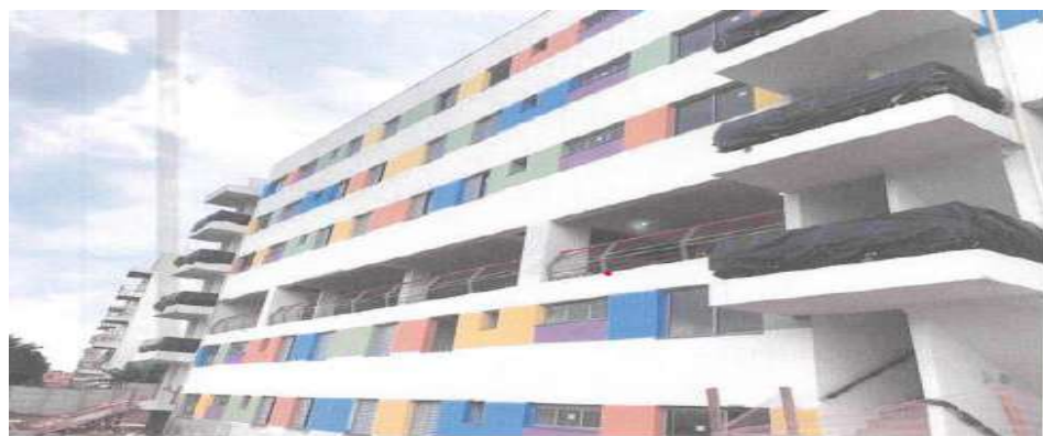
Pintura Externa – Fotos: mai./23.
