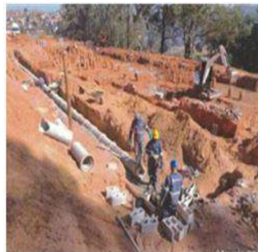
Vila do Sol - Execução de Drenagem Condominial - Foto: mai./23.
