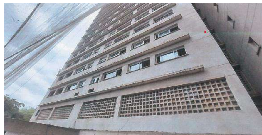
Torres A – Caixilhos e Revestimento Externo – Fotos: mai./23.
