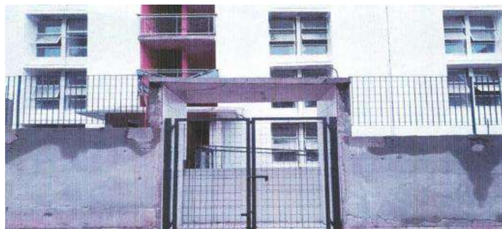
Bloco E – Portão de Entrada - Fotos: mai./23.
