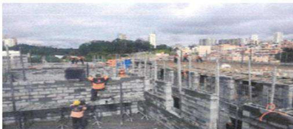
Alvenaria Estrutural – Fotos: mai./23.
