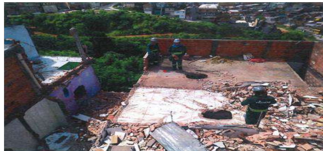
Demolições Setores 10,14 e 26 - Foto: jun/23.
