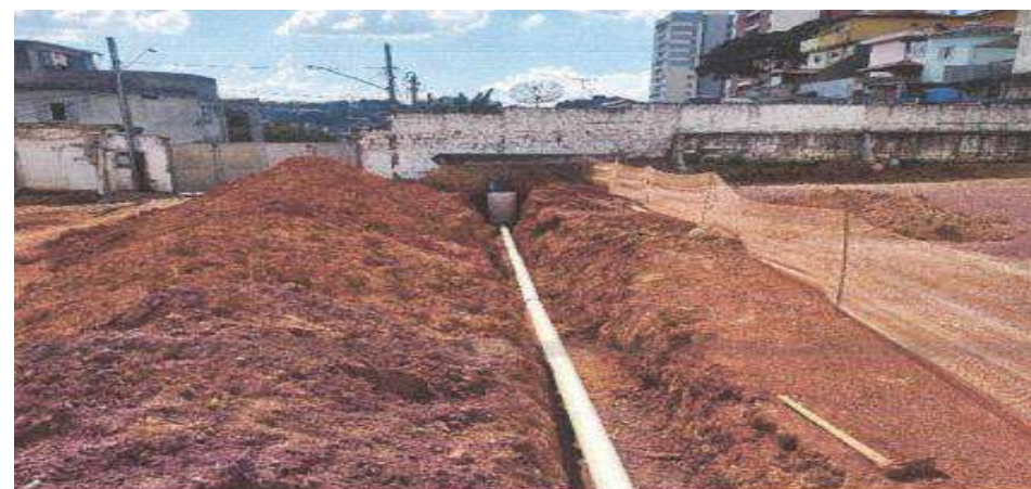
Condomínio A – Assentamento de Tubos para Rede Coletora - Foto: abr./23.
