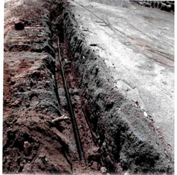
Instalação dos eletrodutos para passagem dos cabos novos.
