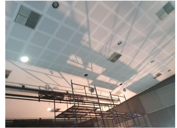
Reforma do forro da plateia
