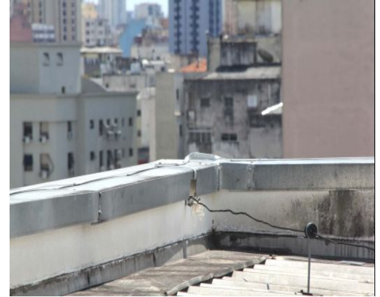
Instalação de SPDA
