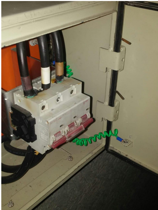
Serviços de elétrica
