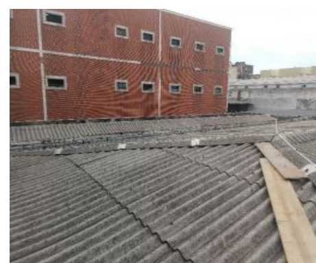
Sistema de Proteção contra Descargas Atmosféricas (SPDA)
