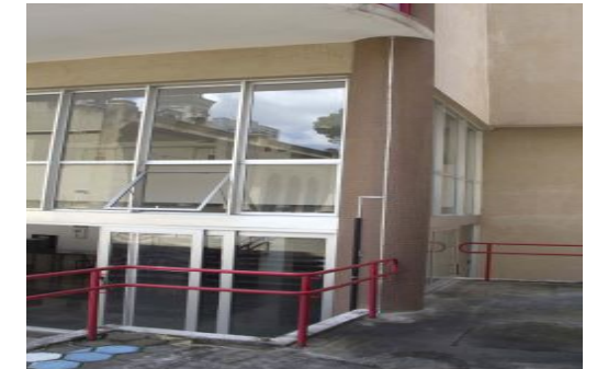
Instalação de SPDA
