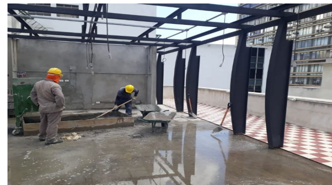
Restauração e recomposição da fachada posterior esquerda.
