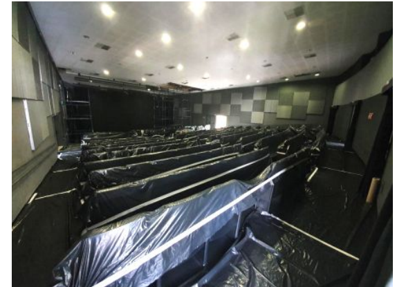
Reforma do forro da plateia
