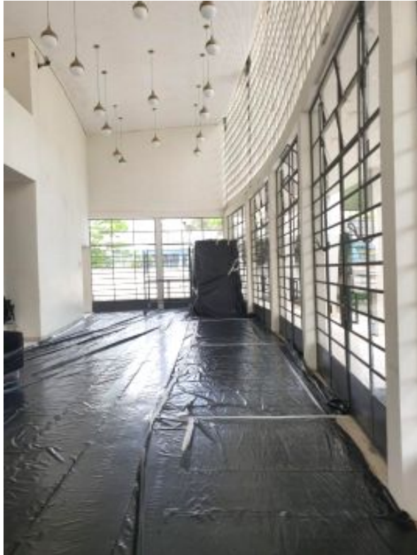
Reforma do forro do saguão de entrada
