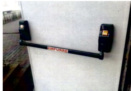
Instalação de barra antipânico
