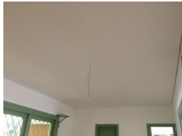
Instalação e pintura do forro de gesso acartonado, no Hall de Entrada
