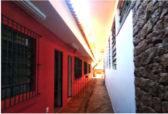
Troca de esquadrias e portas e pintura
