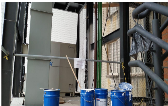
Aplicação de pintura intumescente
