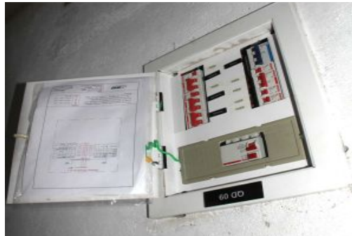
Serviços de elétrica
