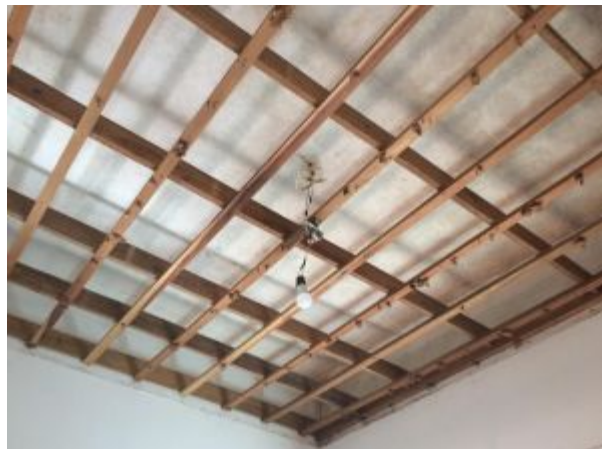
Retirada de forros em placas da Sala de Música
