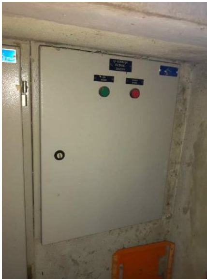
Serviços de elétrica
