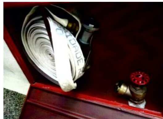
Instalação de mangueira, esguicho e chave de engate
