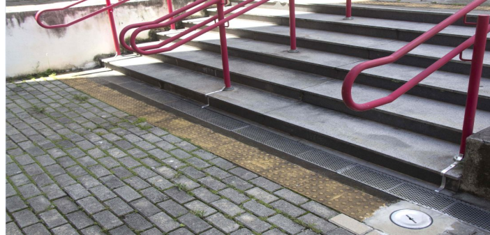
Instalação de SPDA
