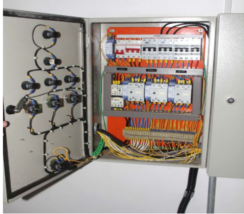
Serviços de elétrica
