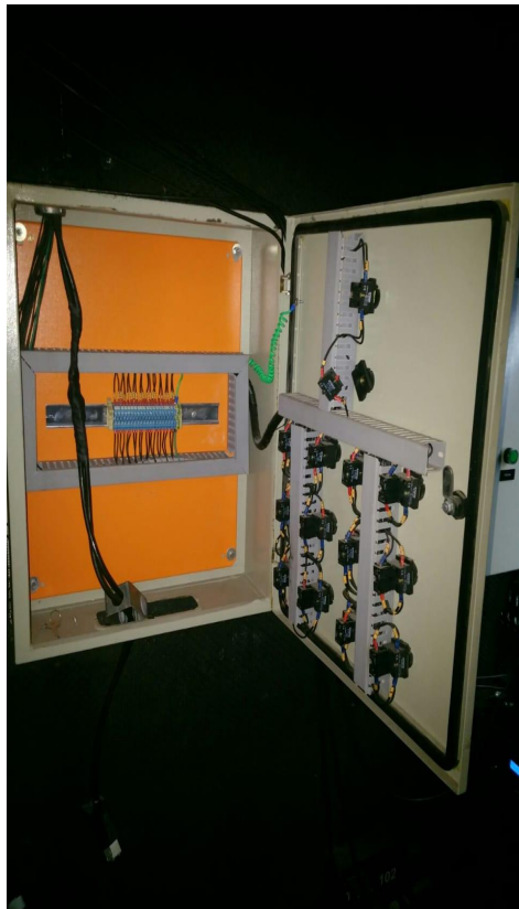
Serviços de elétrica
