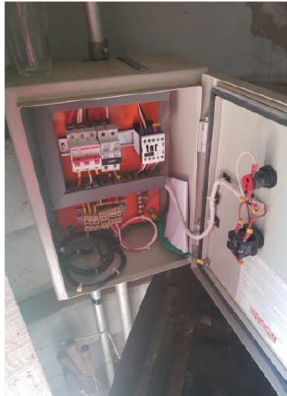
Serviços de elétrica
