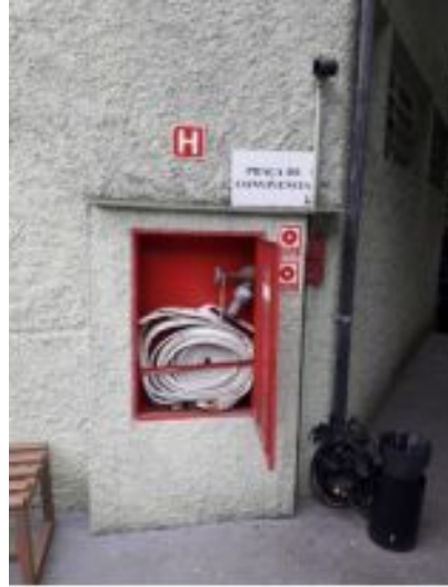
Instalação de esguicho com engate rápido
