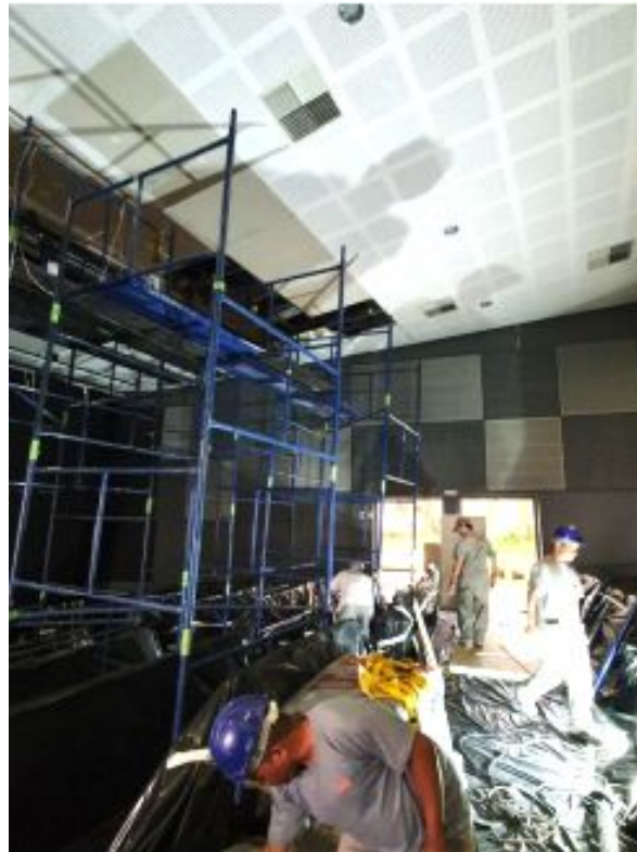
Reforma do forro da plateia
