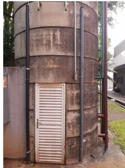
Instalação elétrica no reservatório e SPDA
