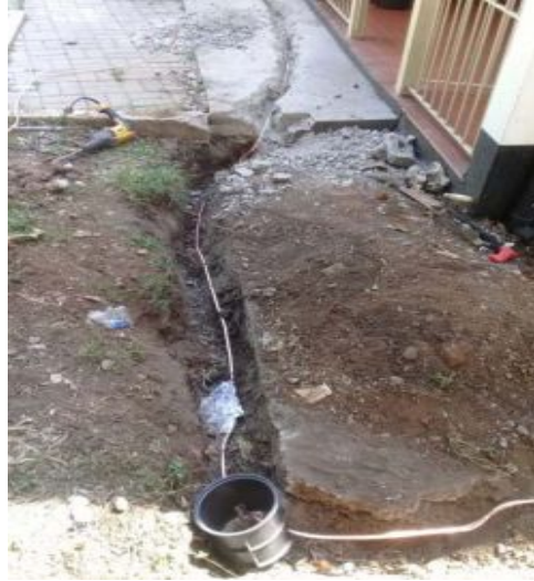
Instalação do SPDA na Biblioteca e no Teatro
