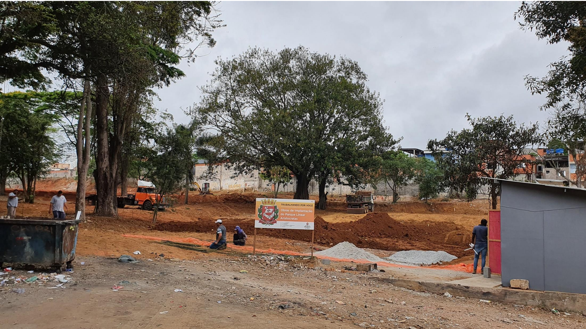
Obras de Implantação em andamento
