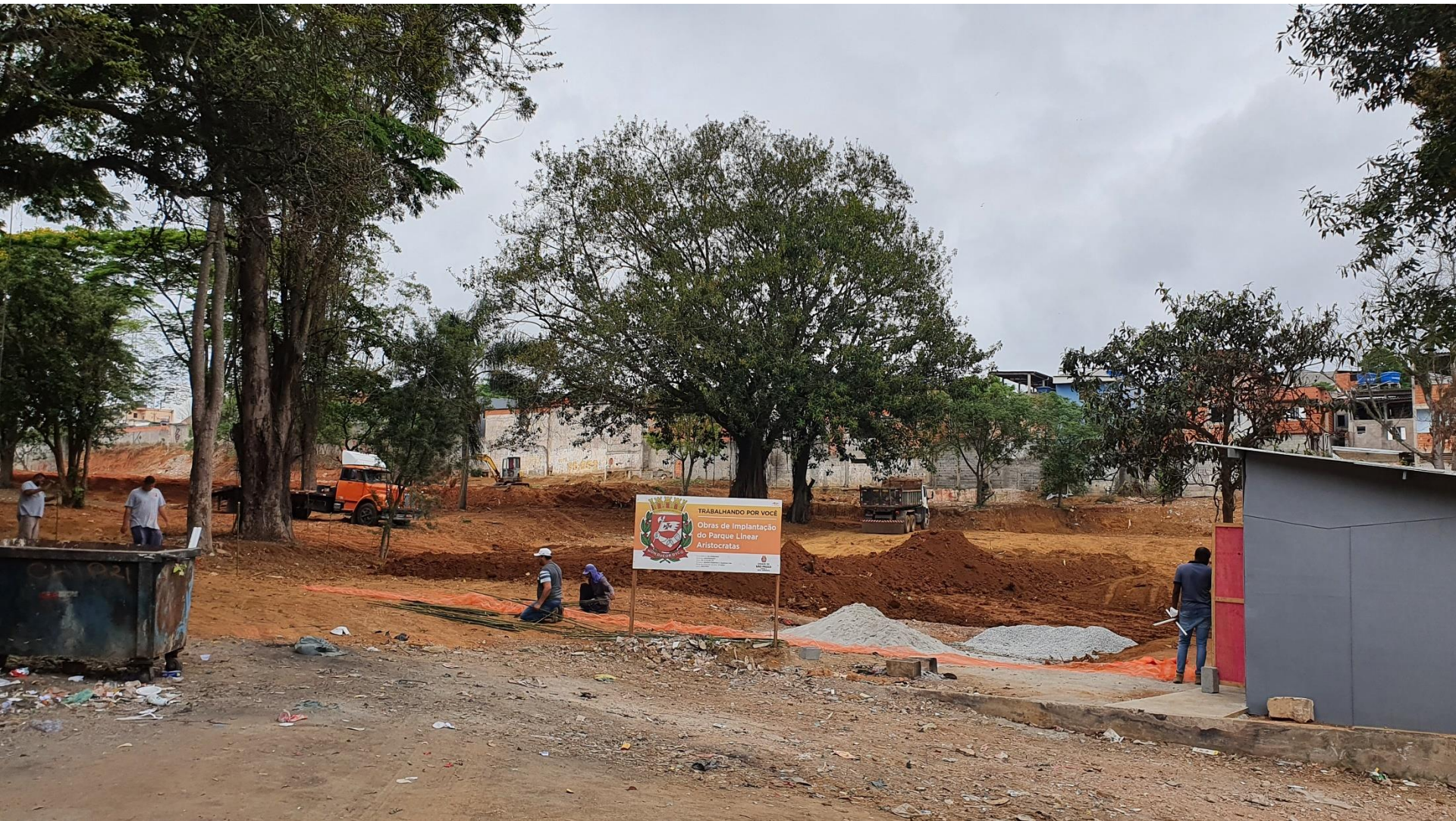
Obras de Implantação em andamento
