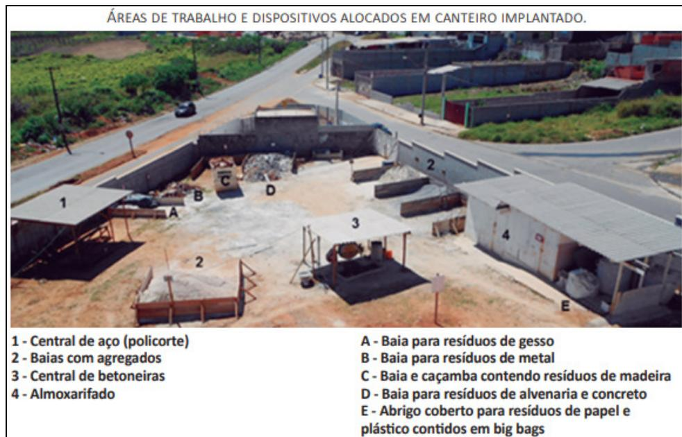
**Organização do canteiro de obras e suas estruturas:** A organização bem executada no canteiro de obras está ligada diretamente com a redução do desperdício de materiais e a redução na geração de resíduos, além de minimizar a perda de tempo na movimentação de materiais, equipamentos, mão-de-obra, fazendo com que haja uma maior eficiência produtiva.
