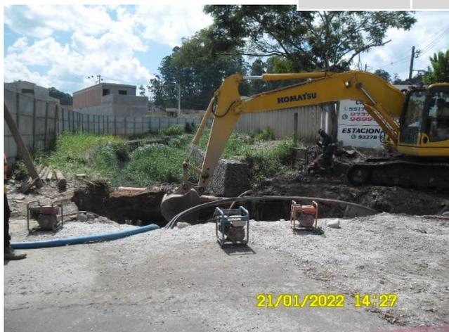
Jardim Tancredo – esgotamento d'água com bomba submersa
