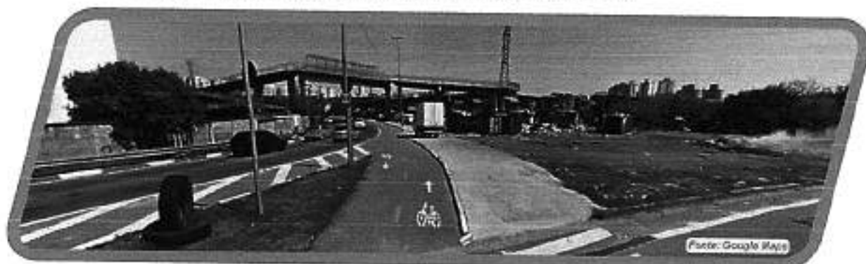
Figura 12 - Ponte Domingos Franciulli Netto
