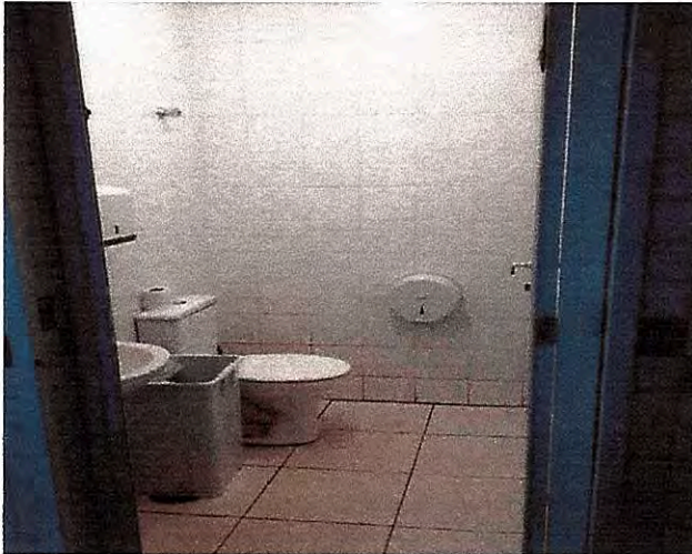
Banheiro Masculino Atendido
