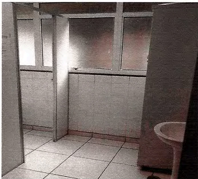
Vestiário e banheiro masculino colaboradores
