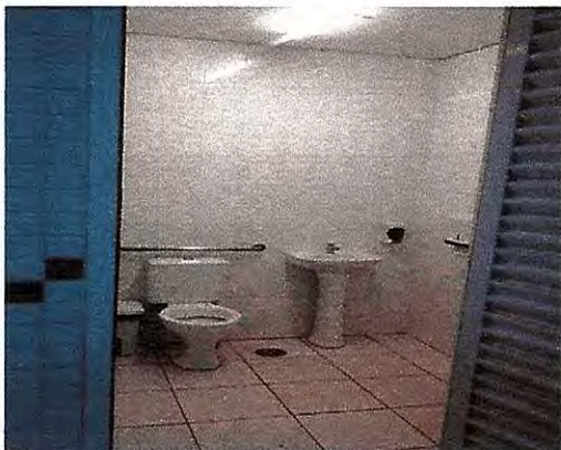
Banheiro com Acessibilidade
