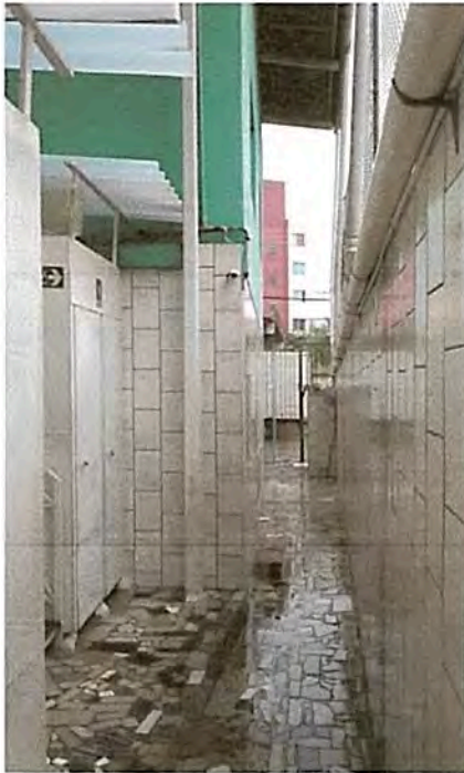
Lateral do corredor central
