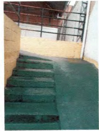
Escada e rampa de acesso à quadra
