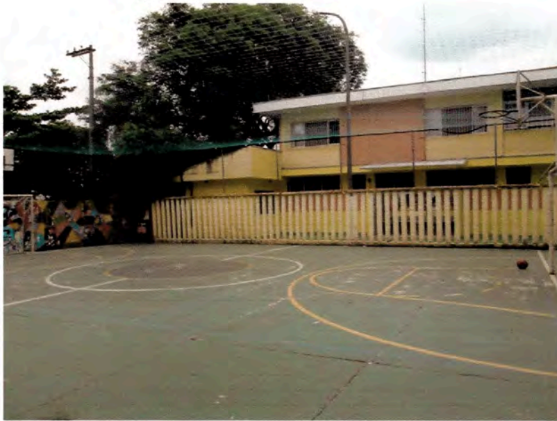
Espaço multi uso coberto interno
