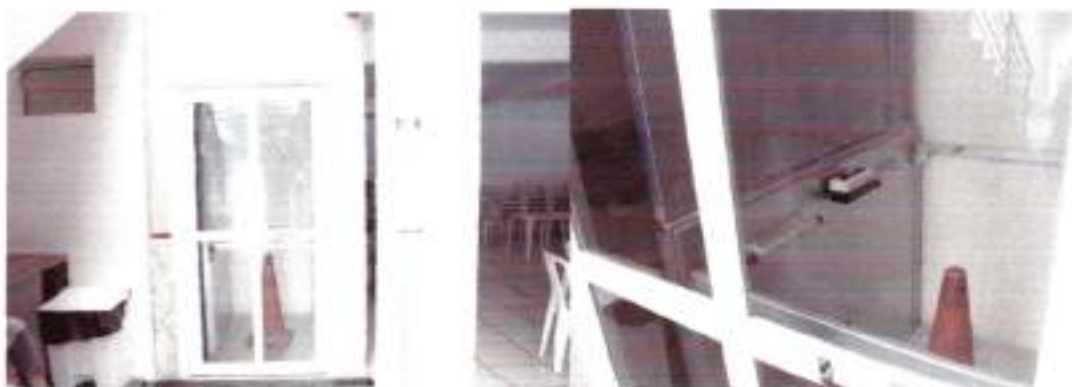
Plataforma Elevatória (Para Pessoas com mobilidade reduzida)
