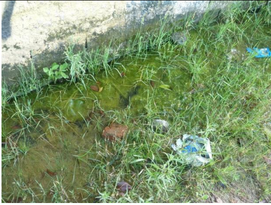
Foto 37. Acúmulo de água e gramíneas em trecho de calçada
