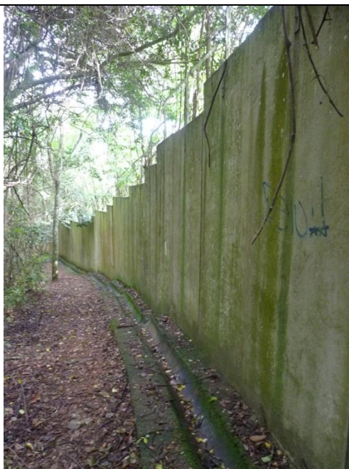
Foto 50. Exemplo de canaleta para escoamento de água na área do parque, margeando o muro de divisa com o SESC Itaquera
