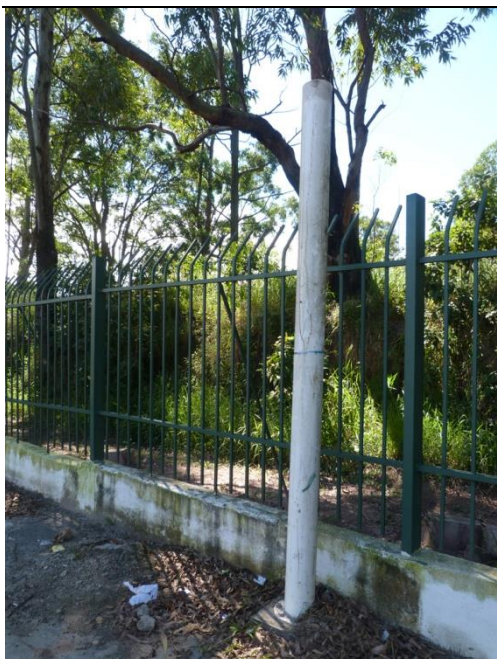
Foto 49. Duto não sinalizado, possivelmente ligado ao aterro desativado
