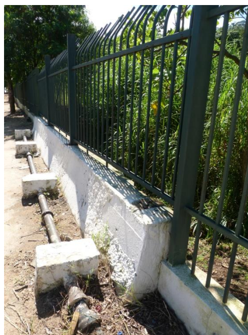
Foto 46. Tubulação de água sobre a calçada e ponto de escoamento de água para a área do parque
