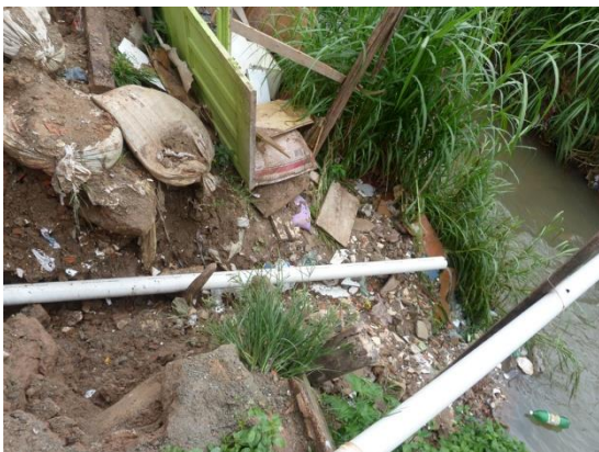
Foto 23. Tubulação de água desviada das residências do outro lado do rio (via aérea) e ponto de despejo de esgoto
