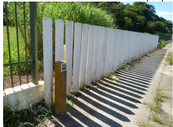
Foto 44. Trecho de passagem de dutos de
