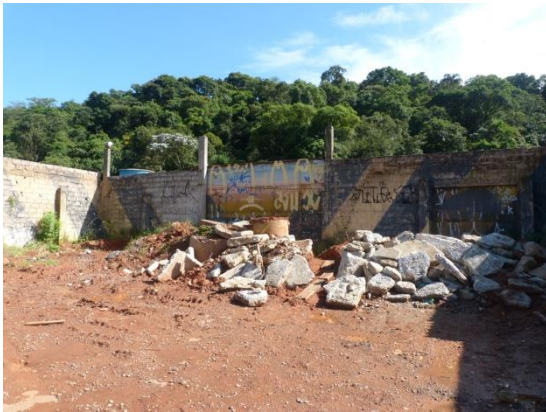
Foto 39. Bloqueio da entrada da antiga casa de shows
