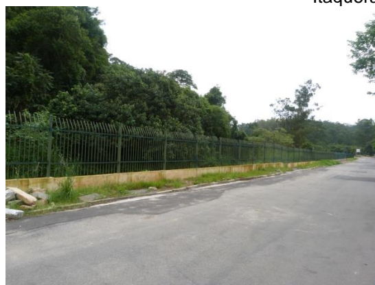
Foto 52. Rua Jacu Pêssego e as más condições das calçadas para pedestres ao longo do gradil do parque
