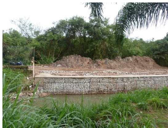
Foto 34. Obra de contenção realizada para instalação do gradil em área antes erodida
