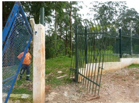
Foto 6. Ponto de acesso de emergência ao parque, destrancado
