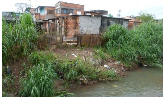
Foto 30. Habitações construídas às margens do rio, próximo a áreas erodidas
