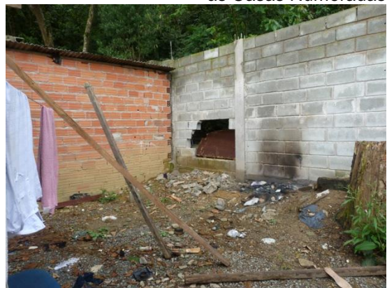
Foto 24. Abertura no muro do parque, onde são depositados resíduos sólidos, além de possível rota de fuga para o interior do PNMFC
