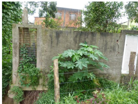
Foto 14. Detalhe sobre parte da cerca que já se perdeu e muro prestes a escorregar
